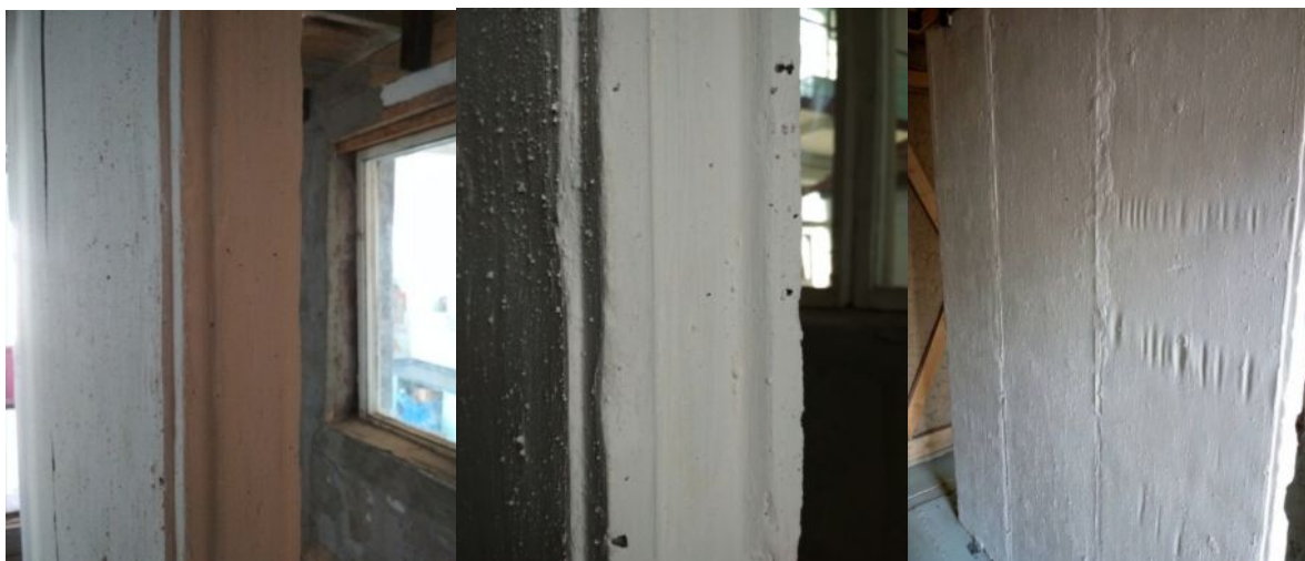
Рис. 1. Соединение типа «папа-мама»
