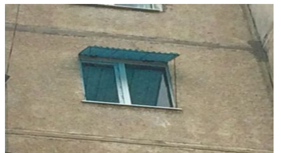
Рис. 2. Устройство козырьков над окнами: а) из металлических листов; б) из пластиковых листов
