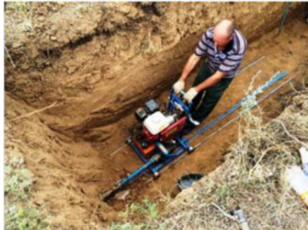
Прокол грунта с помощью Продавливание в грунт трубы гидрооборудования
