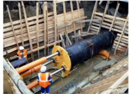
Прокол грунта с помощью Продавливание в грунт трубы гидрооборудования
