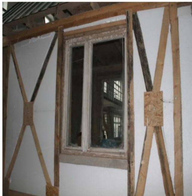
Рис.3. Общий вид заполнения каркаса между стойками и раскосами с пенопластом
