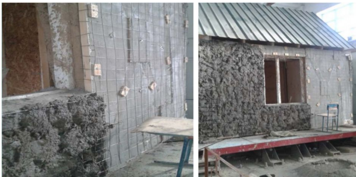
Рис.4. Установка вертикальных сеток снаружи с оставлением зазора 15-20 мм и штукатурка цементно-песчаным раствором
