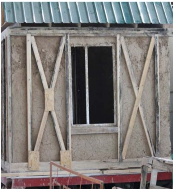
Рис.3. Общий вид заполнения каркаса между стойками и раскосами с пенопластом
