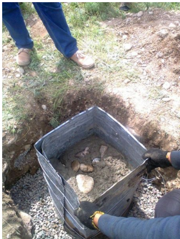
Рис.П.6.2.2. Возведение фундамента-1 на гравийной подушке
