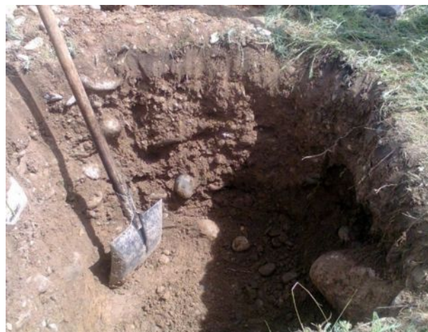
Рис.П.6.2.4. Котлован для фундамента-2 на естественном основании
