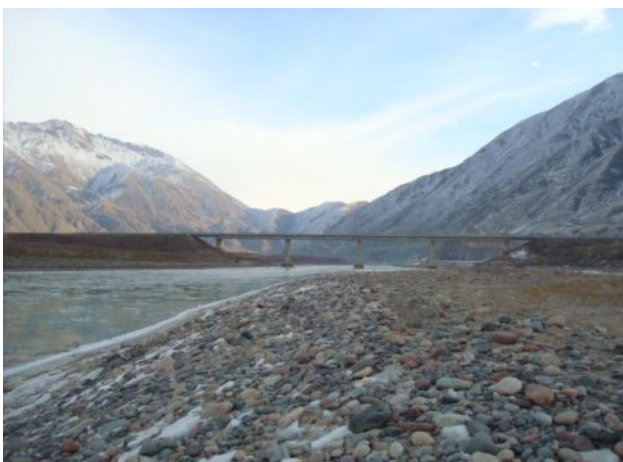
Рис.П.6.1.1. Общий вид моста на 318км автодороги Бишкек-Ош
