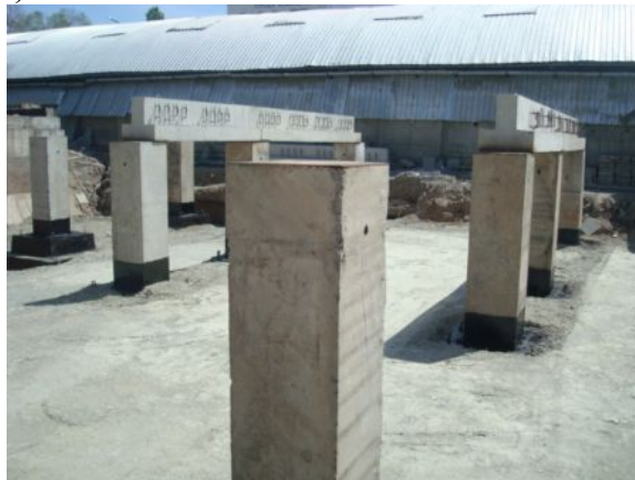
Рис. 4.1. Возведение искусственного основания промежуточных фундаментов и опор подземного перехода:
