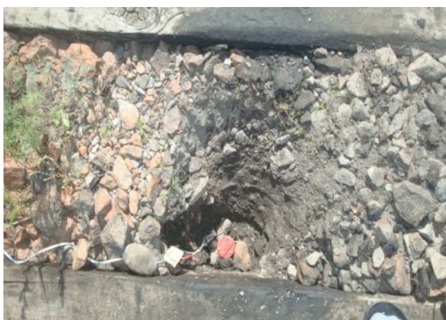
Рис.П.6.2.7. Установка датчика ускорения СГ-10 вблизи шпалы железнодорожного пути – источника колебаний
