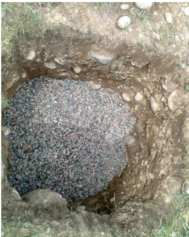
Рис.П.6.2.1. Гравийная подушка под фундамент
