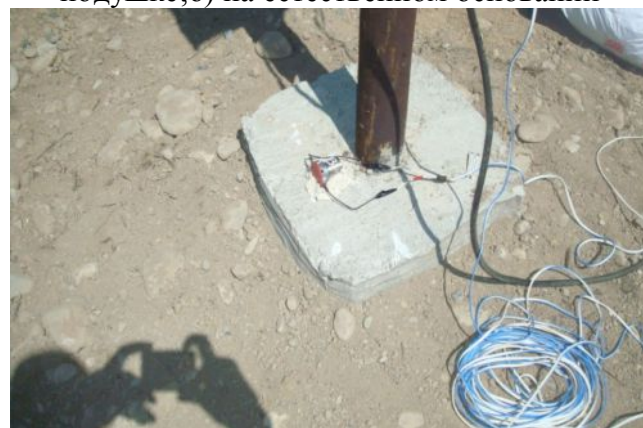
Рис.П.6.2.10. Установка датчиков СГ-10 на фундаменты опор
