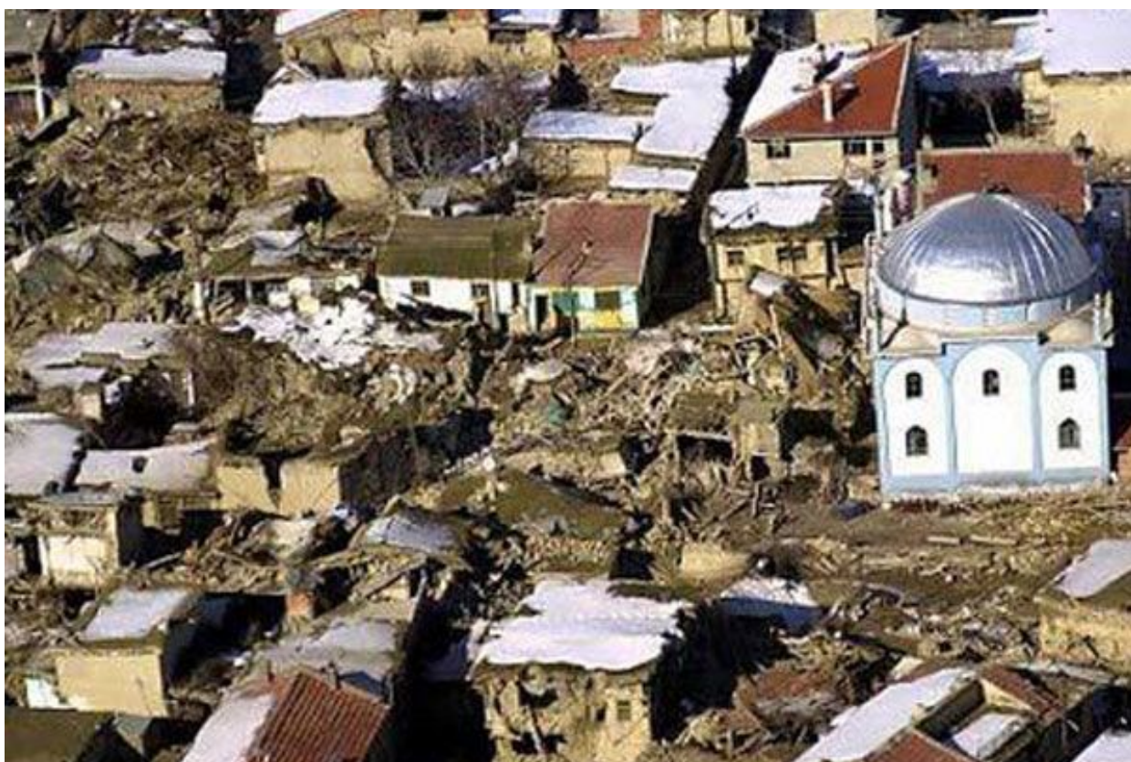
Рис. 1.7. Разрушение жилых домов при сильных землетрясениях
