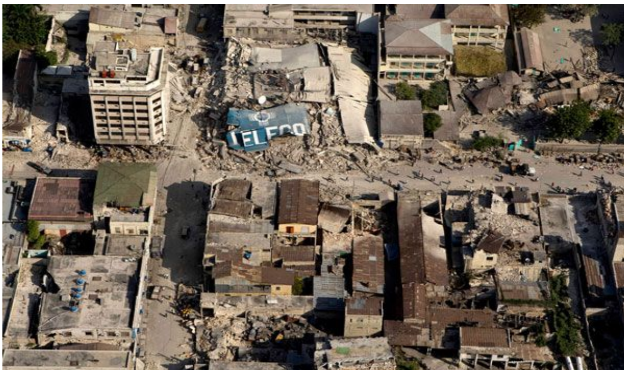
Рис. 1.6. Разрушительное землетрясение на Гаити в 2010-году
