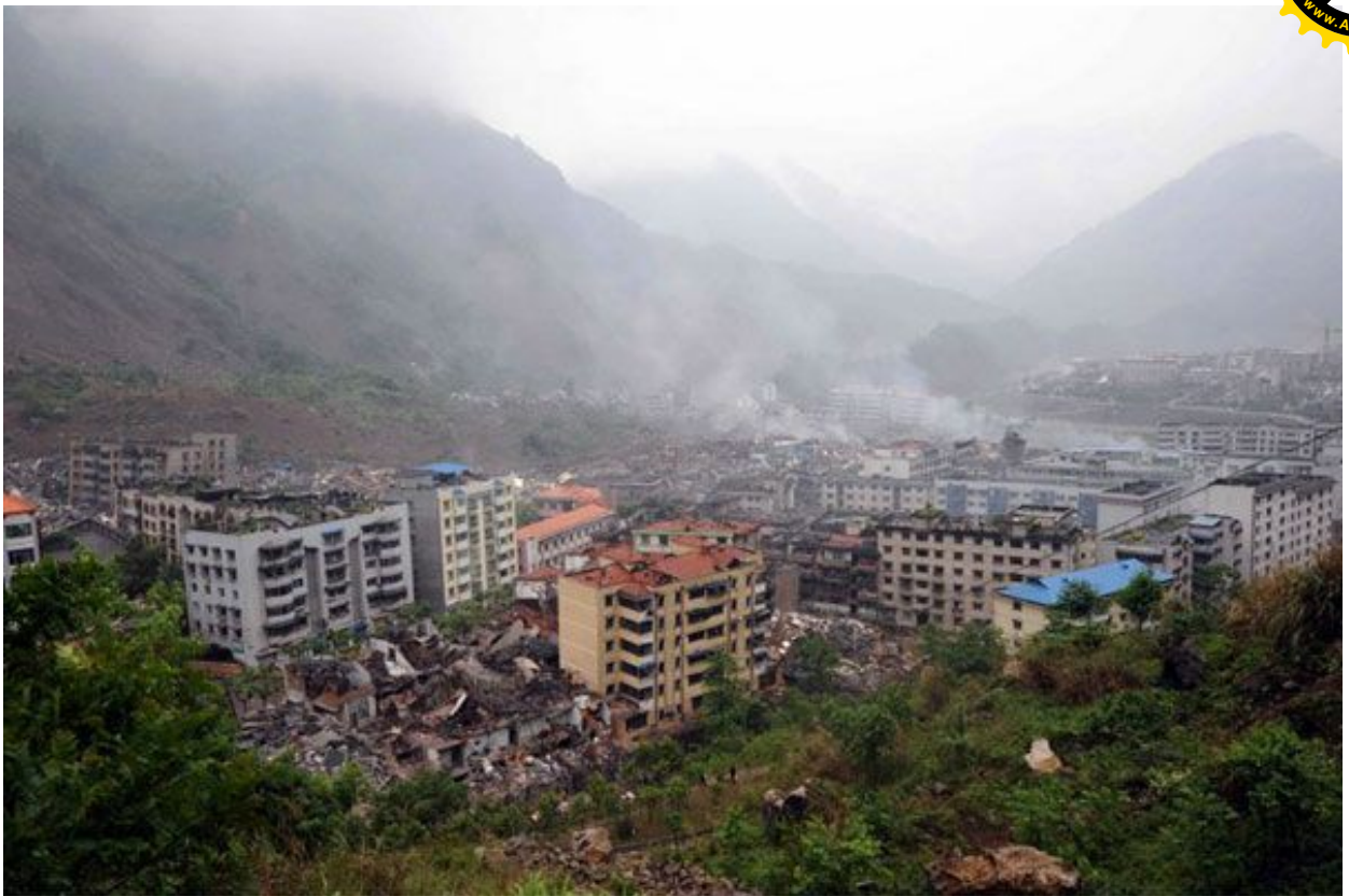
Рис. 1.2. Разрушение зданий и сооружений в Китае
