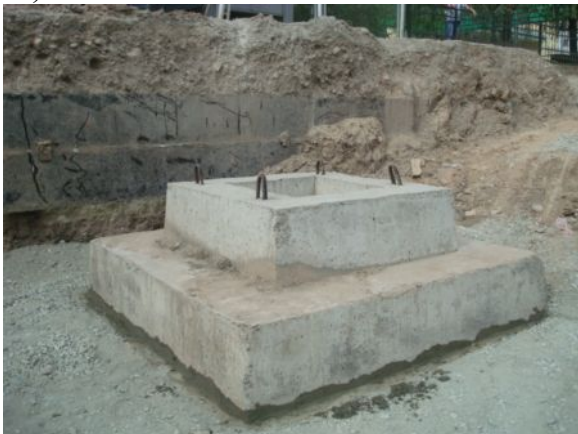
Рис. 4.1. Возведение искусственного основания промежуточных фундаментов и опор подземного перехода:
