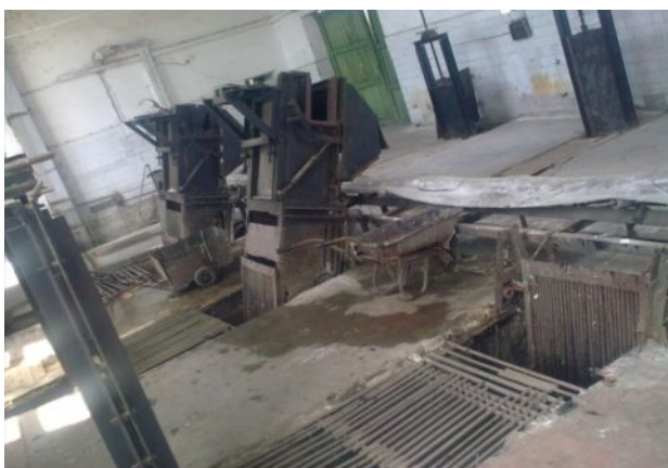
Рис.1. Решетки очистного сооружения г.Ош до реконструкции
