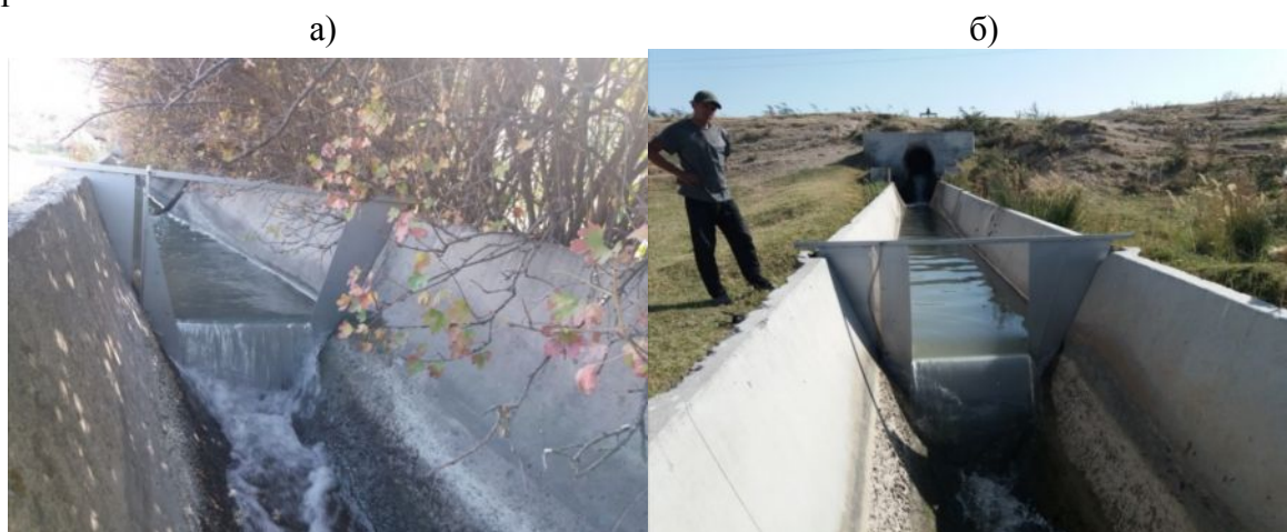
Рис 2. Трапециевидальный (а) – на канале «Жантай» с.р. Ала-Арча и прямоугольный (б) – на канале «Подпитка-2» ЗБЧК водосливы в работе. Вид с нижнего бьефа.
