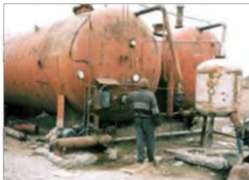
Рис. 3. Действующая БЭМС-120 Сокулукский район. Объем реактора 120 м 3
