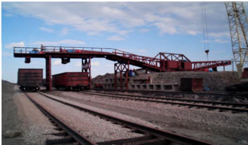
Рис.3. Конструкция комплекса ДСКА производительностью 1000 т/час в варианте поставки ОАО “Шубарколь Комир” (Республика Казахстан)
