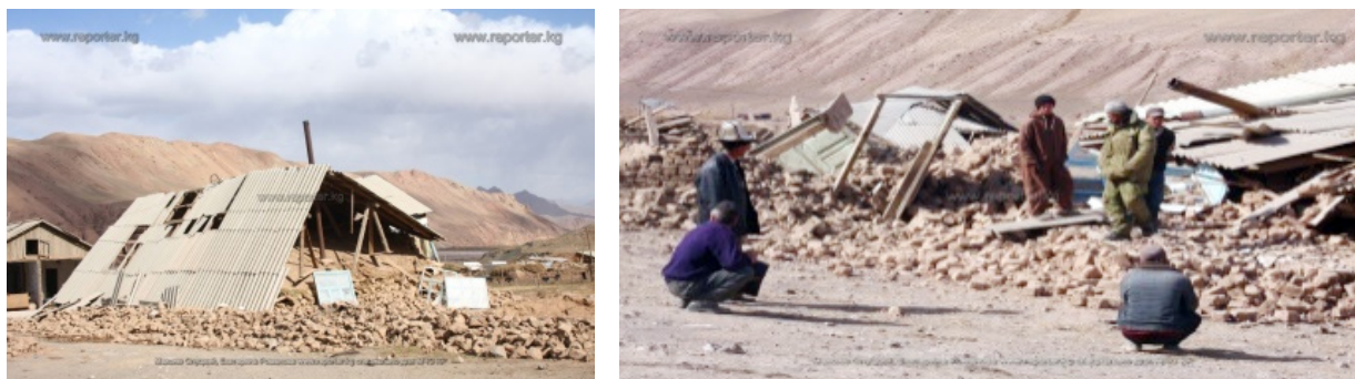
Рисунок 2 – Состояние домов после землетрясения в с. Нура, 2008 г.
