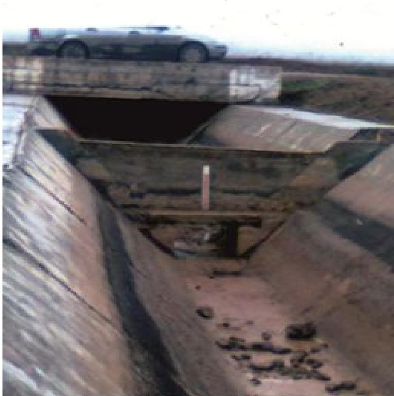
Рис.3.11 Водомерное сооружение типа «Прямоугольный насадок» на Р-23 системы ВБЧК. а – вид с верхнего бьефа; б – вид с нижнего бьефа
