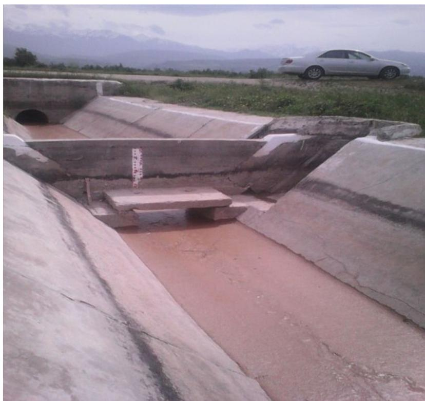
Рис.3.9 Водомерное сооружение типа «Прямоугольный насадок» на Р-21 системы ВБЧК. а - вид с верхнего бьефа; б – вид с нижнего бьефа
