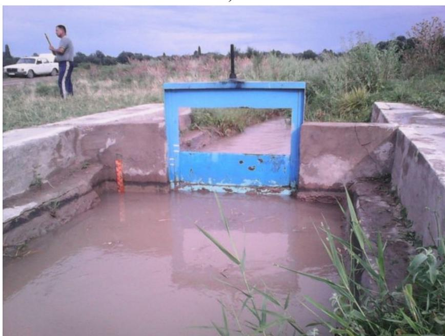
Рис.3.13 Водомер типа «Водослив-насадок» на Р-8 системы ЗБЧК (замер воды осуществляется насадком) а – вид с верхнего бьефа; б – вид с нижнего бьефа [93]
