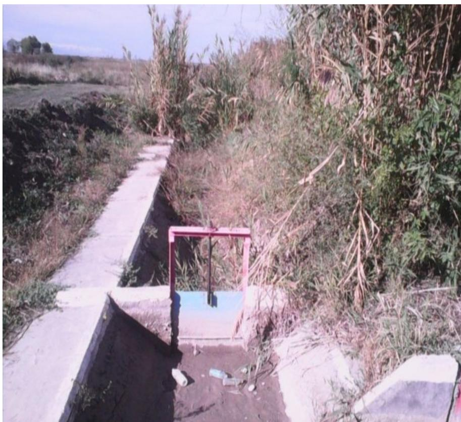
Рис 2.2 Водомер типа «Фиксированное русло» (оно расположено за плоским щитом) на канале КРВХ-2 Р-24 системы канала ЗБЧК [26]
