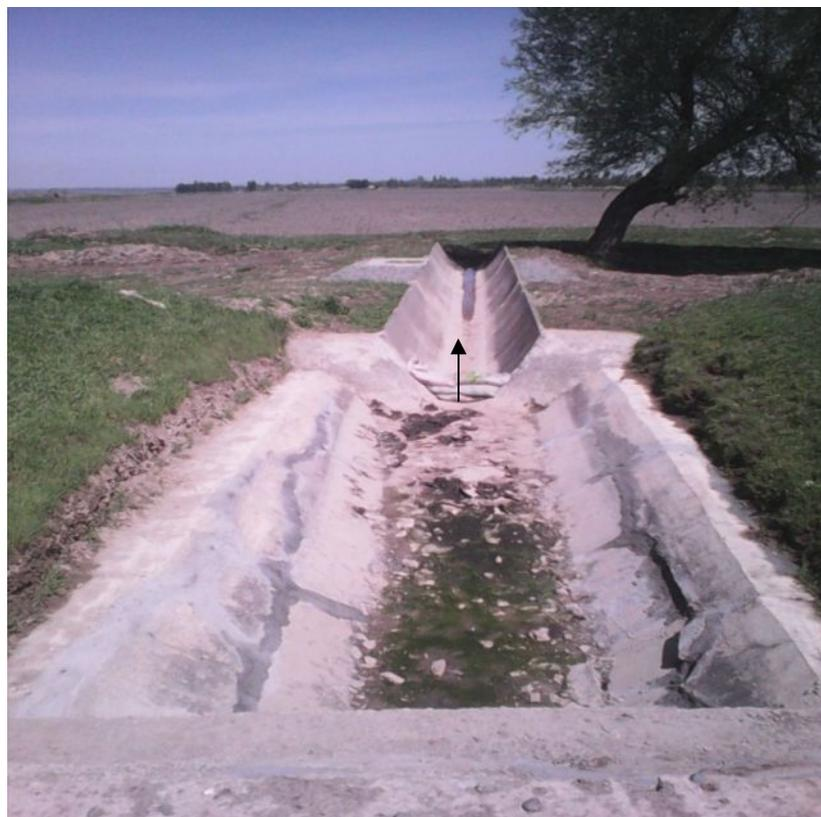
Рис.3.2 Водомеры типа «Прямоугольный насадок» (а) и «Фиксированное русло» (б) на Р-20-2 системы ЗБЧК (виды с верхнего бьефа) [16,33,37,86]
