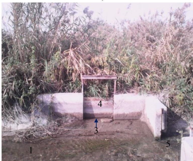
Рис.2.4 Вододелители на внутрихозяйственных каналах СХ-1 (а) и СХ-3 (б) распределитель Р-24 системы ЗБЧК. 1 – межхозяйственный канал; 2 – щит; 3 – вход во внутрихозяйственный канал; 4 – щит; 5 – начало внутрихозяйственных каналов (на которых в удалении 35-40м от головного регулятора размещены водомеры типа «Фиксированное русло», которые заилены илом и засорены камышом) [26,93]
