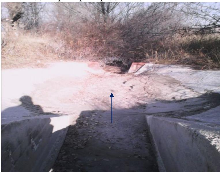
Рис.2.18 Водомер типа «Водослив» на отводе из МК «Туш» (верхний бьеф заилен наносами) [43]
