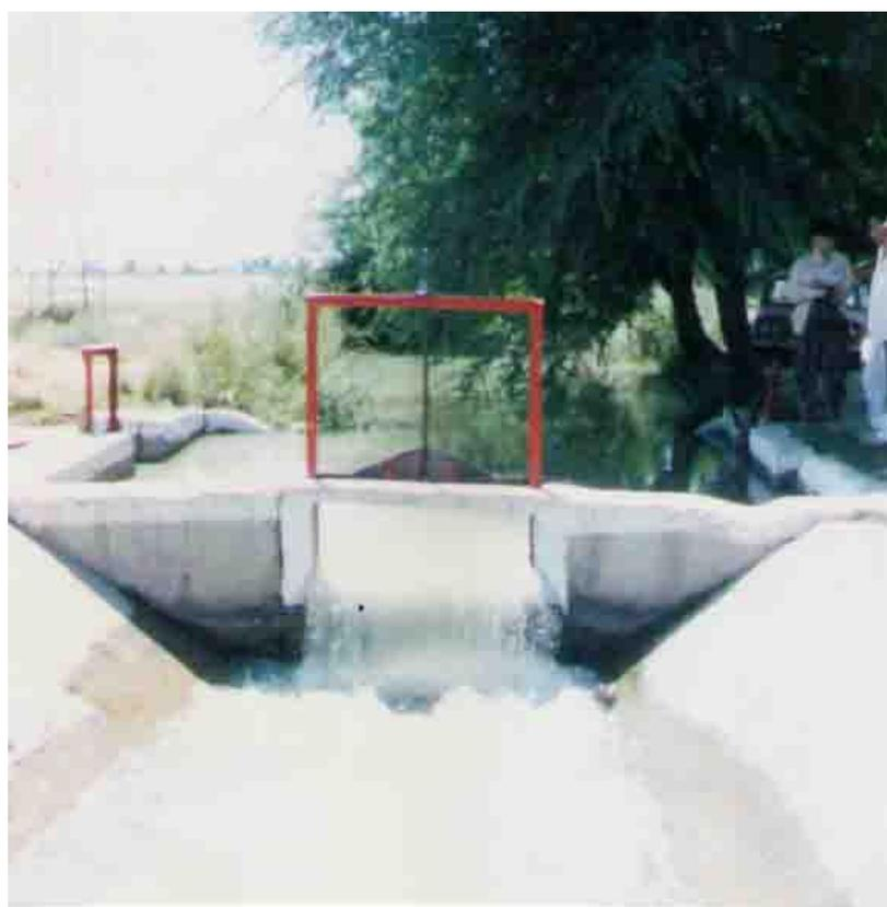
Рис.4.1 Щит-водомер типа водослив с тонкой стенкой на вододелительном сооружении на распределителе Р-7-13 прямой системы АМК [2,13]
