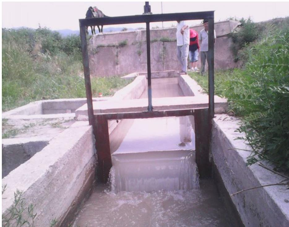
Водомерное сооружение в работе – замер расходов воды осуществляется прямоугольным водосливом. а – вид с верхнего бьефа; б – вид с нижнего бьефа
