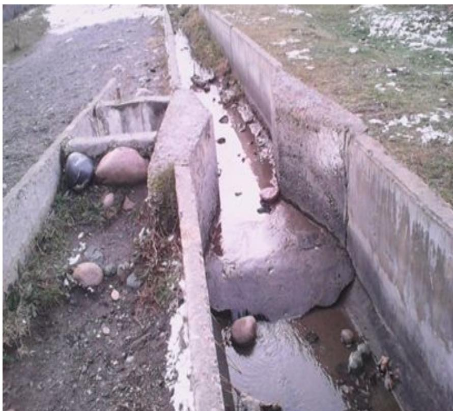
Рис. 2.12 Водомер типа «Лоток» Вентури на отводе канала «Джеламыш» с.р. «Джеламыш» [16,33,37]
