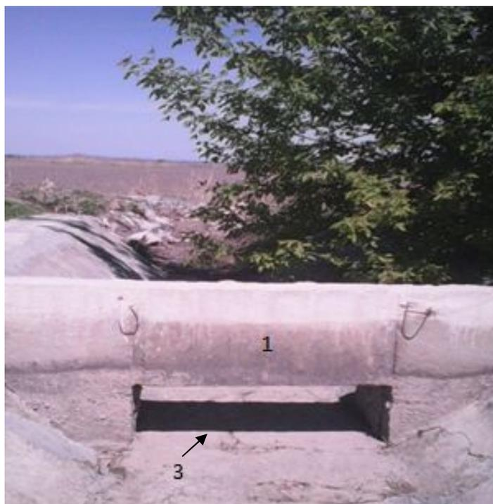
Рис.3.3 Водомер типа «Прямоугольный насадок» на Р-20-3 системы ЗБЧК.
