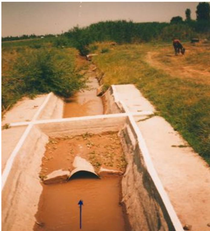
Рис. 2.23 Водомер типа «Насадок» (вид с верхнего бьефа), который не используется для учета воды при подаче ее водопотребителям [29]
