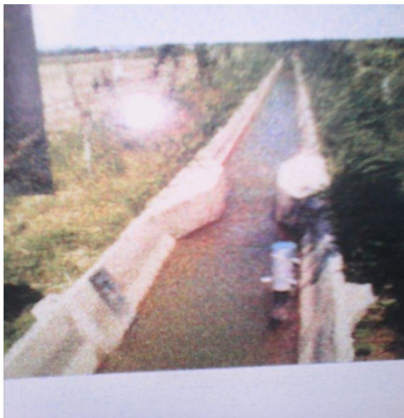
Рис. 2.10 Водомер типа «Лоток» Вентури на лотковом канале параболического сечения[16,33,37]
