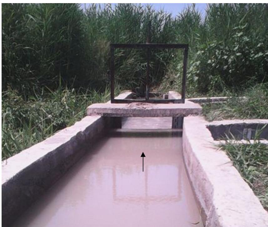
Водомерное сооружение а - без воды (вид с нижнего бьефа); б - водомерное сооружение в работе – замер воды осуществляется прямоугольным водосливом (вид с верхнего бьефа)
