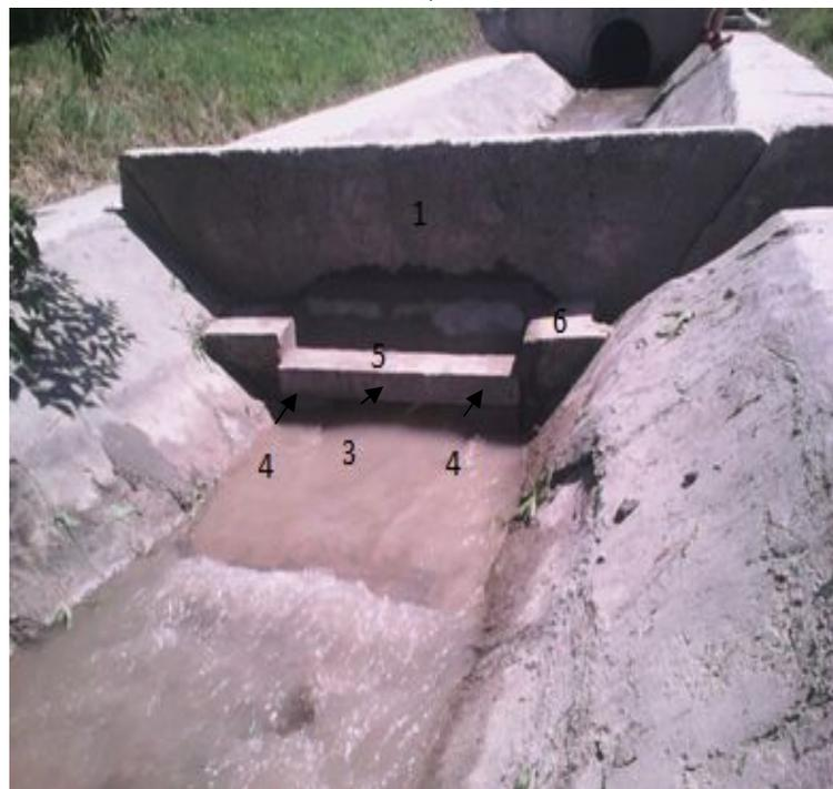
Рис.3.4 Водомер типа «Прямоугольный насадок» на Р-20-3 системы ЗБЧК.
