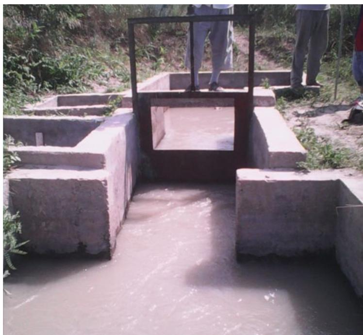
Водомерное сооружение в работе: а – замер расходов воды осуществляется на прямоугольном водосливе (вид с нижнего бьефа); б – замер расходов воды осуществляется насадком (вид с нижнего бьефа)
