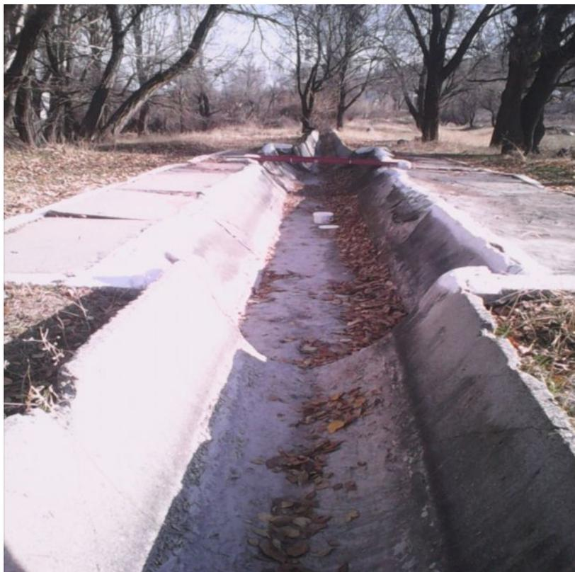
Рис. 2.9 Водомер типа «Фиксированное русло» трапецеидального поперечного сечения на лотковом канале Белек с.р. Ала-Арча[40]
