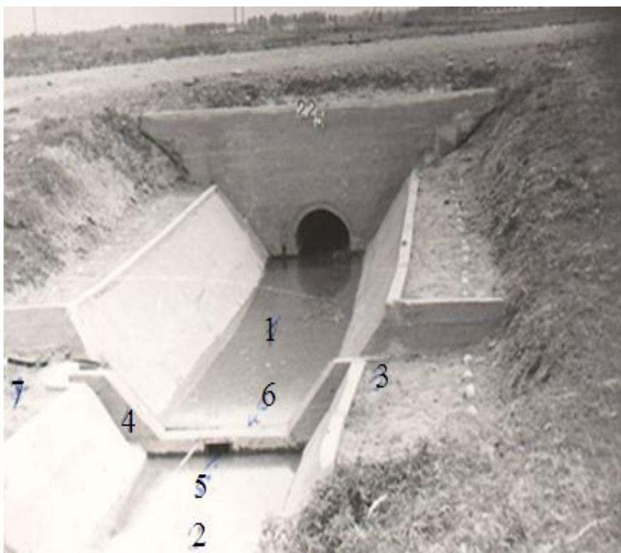
Рис.2.15 Типовой водомер с водосливом Иванова на Р-12-5 системы ЗБЧК [13]
