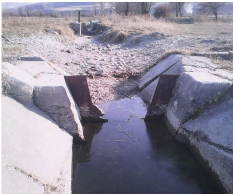
Рис.2.19 Водомер типа «Водослив» на отводе из МК «Туш» (водослив сломан) [33,37]
