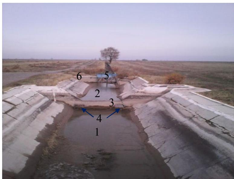
Рис.2.20 Водомер типа «Водослив» на распределителе из ВБЧК
