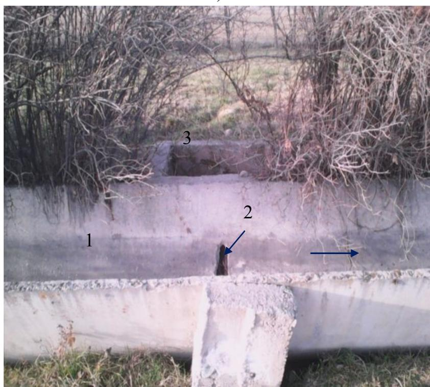
Рис. 2.7 Водомер типа «Фиксированное русло» на лотковом канале «Жантай» с.р. Ала-Арча. а) общий вид с верхнего бьефа; б) вид сбоку.
