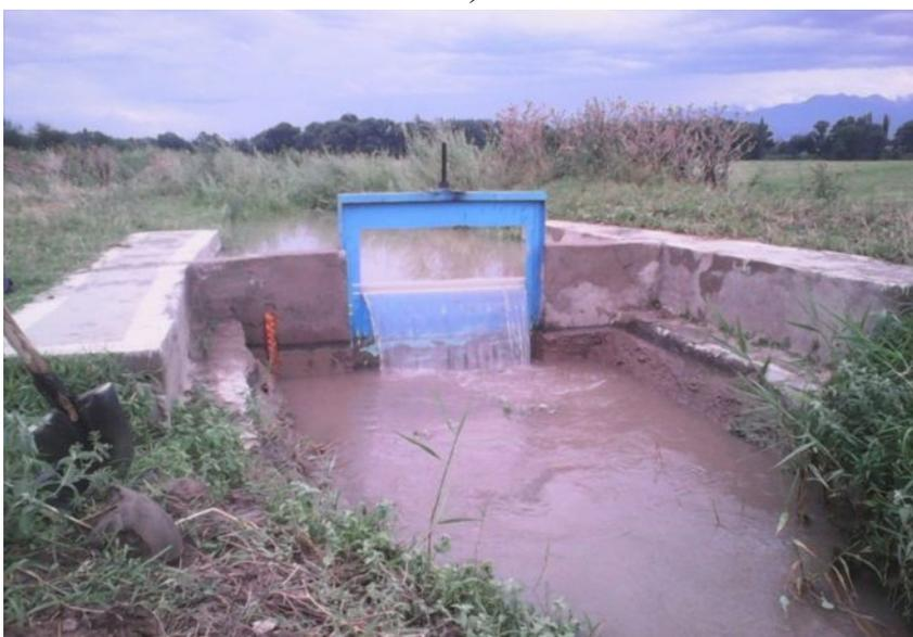
Рис.3.12 Водомер типа «Водослив-насадок» на Р-8 системы ЗБЧК (замер воды осуществляется водосливом). а – вид с верхнего бьефа; б – вид с нижнего бьефа [93]
