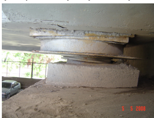
г – Опорная часть, скользящая, из фторопласта и металла
