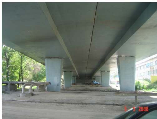
б – Промежуточные опоры и пролетные строения снизу
