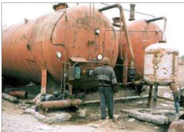
Рис. 8 БЭМС-120 Сокулукский район Объем реактора, м 3 – 120; Пропускная способность по навозу, т/сутки – 8-16; Пропускная способность по навозу, т/год – 2800-5600; Производительность по биогазу, м 3 /сутки – 120-360; Производительность по биогазу, м 3 /год – 43000-86000; Установленная мощность, кВт – 7
