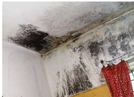
Фото 2 – Дефекты трехслойных стен внутри помещений
