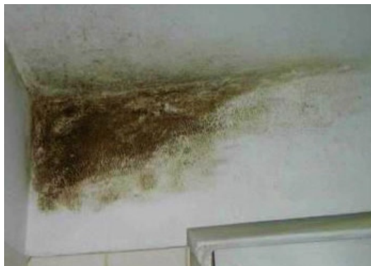
Фото 2 – Дефекты трехслойных стен внутри помещений
