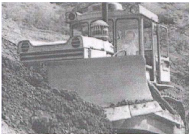
Рис. 4.17. Фрагмент засыпки траншеи с использованием бульдозера с увеличенным отвалом.
