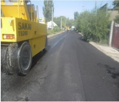
Рис.1. Процесс укладки асфальтобетонной смеси с золой уноса
