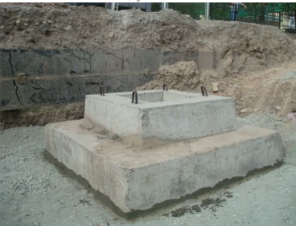
Рис. 1. Возведение искусственного основания промежуточных фундаментов и опор подземного перехода: а) послойное возведение искусственного основания из ГПС (оптималка), б) послойное уплотнение искусственного основания из ГПС (оптималка), в) армирование и установка опалубки подошвы фундамента, г) монолитная железобетонная подошва фундамента, д) установка фундаментов стаканного типа, е) монтаж железобетонных ригелей на опоры (колонны).
