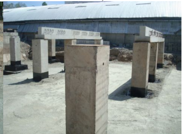
Рис. 1. Возведение искусственного основания промежуточных фундаментов и опор подземного перехода: а) послойное возведение искусственного основания из ГПС (оптималка), б) послойное уплотнение искусственного основания из ГПС (оптималка), в) армирование и установка опалубки подошвы фундамента, г) монолитная железобетонная подошва фундамента, д) установка фундаментов стаканного типа, е) монтаж железобетонных ригелей на опоры (колонны).
