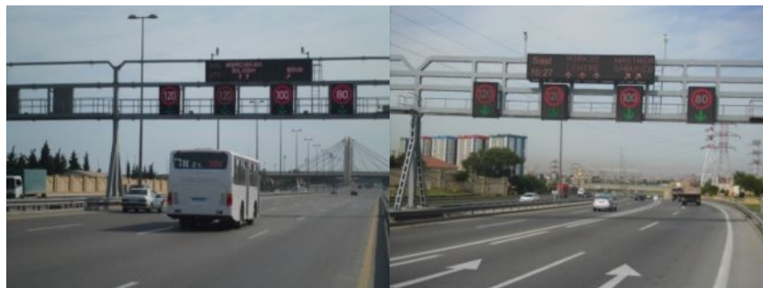
Рис. 3. Электронные табло (ИТС) с указанием скоростных режимов по полосам, предварительного направления транспортных средств, а также времени суток, температуры воздуха и асфальтобетонного покрытия и других климатических условий
