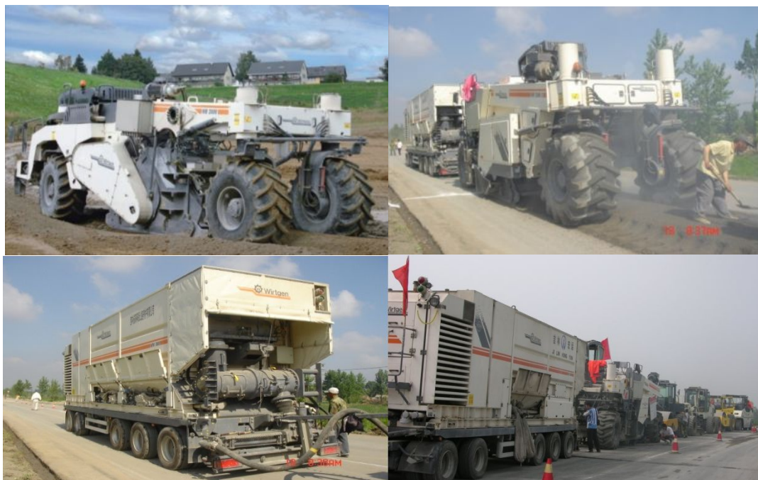
Рис. 3. Фрагменты техники и технологии холодной реактивации на месте строительства
