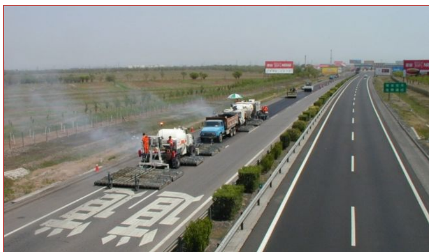
Рис.2. Система машин, используемых при рециклинге автомобильных дорог
