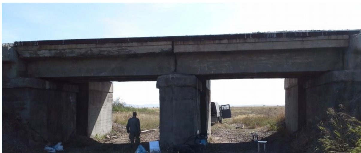
Рис. 1. Общий вид моста нечетного пути до проведения работ по усилению
