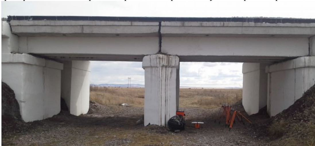
Рис. 2. Общий вид моста нечетного пути после проведения работ по усилению
