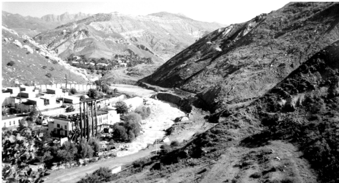
Рис. 3. Бывший завод № 3 гидрометаллургической переработки урановой руды. На переднем плане низовой откос дамбы хвостохранилища № 3
