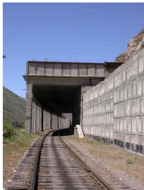
Защитная галерея на участке железнодорожной линии Бишкек – Балыкчи.
