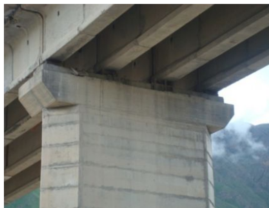
б) промежуточная опора и пролетное строение снизу
