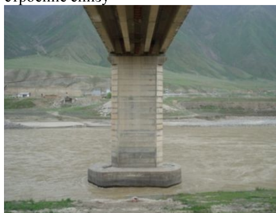
г) общий вид опоры и опорной части в третьей опоре
