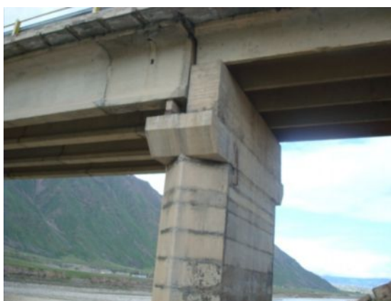
в) общий вид опоры и опорной части в первой опоре
