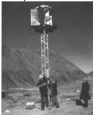
Рис. 16. Роторная ветроустановка. Опытный образец
