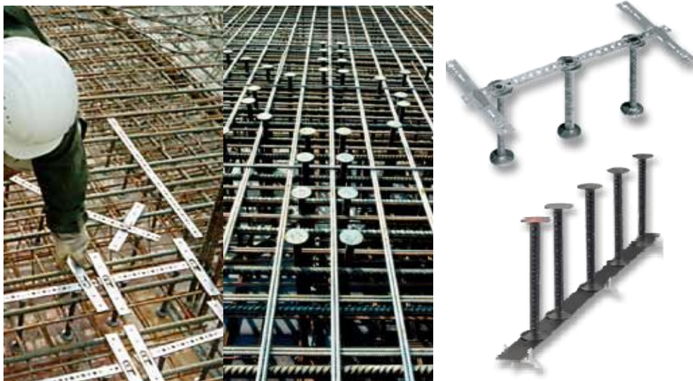
Рис. 2.8. Арматурные системы HDB и HDB-S
