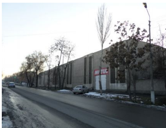
Рис. 1.20. Двухэтажный правительственный гараж. г. Бишкек.
