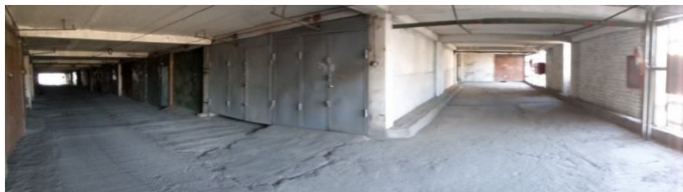
Рис. 1.19. Многоэтажный гараж-стоянка по ул. Л. Толстого. г. Бишкек. Внутреннее пространство.
