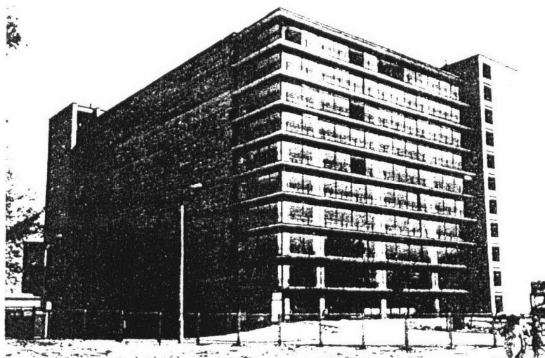
Рис. 1.4. Многоэтажный гараж с наклонными полами на 540м/м, ул. Киевская, г. Москва. Моспромпроект, 1976 г.
