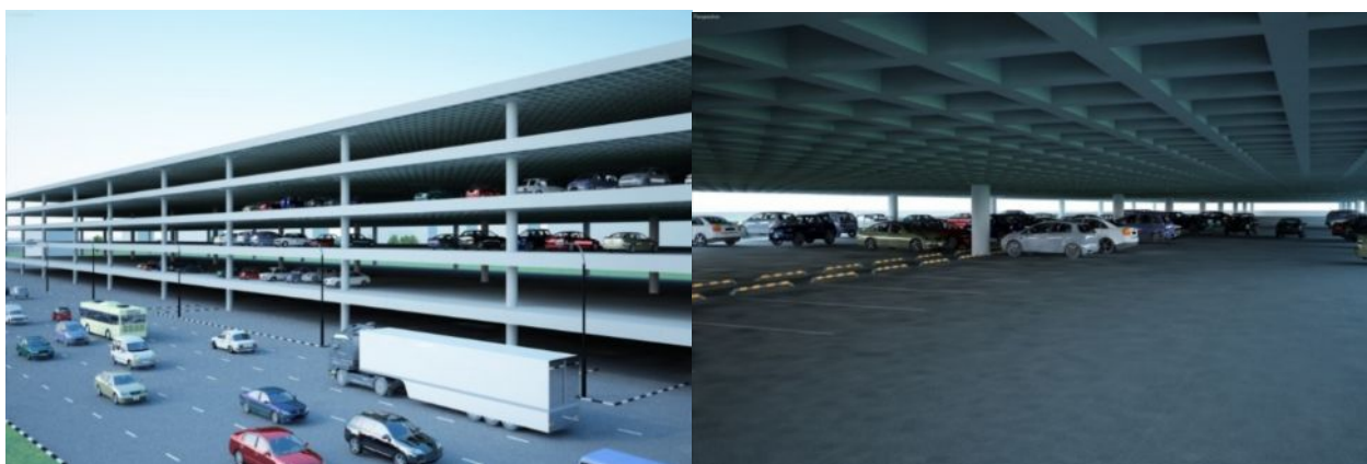
Рис. 1.32. Железобетонный каркас открытого многоярусного паркинга
