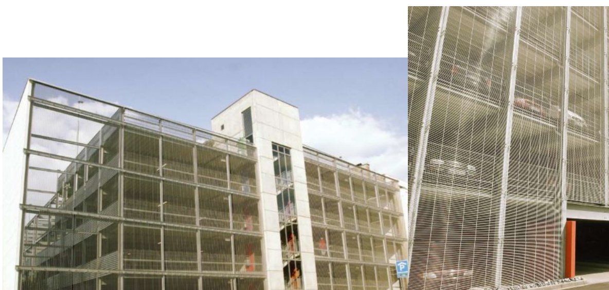
Рис. 2.11. Легкое сетчатое ограждение открытых паркингов
