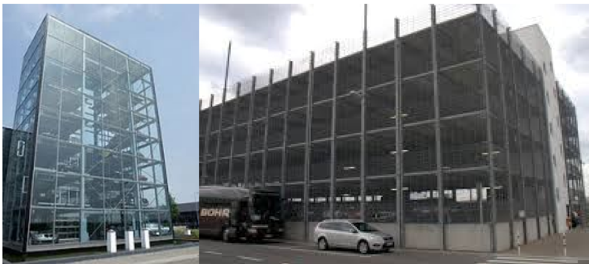
Рис. 2.10. Ограждение многоэтажных гаражей-стоянок
