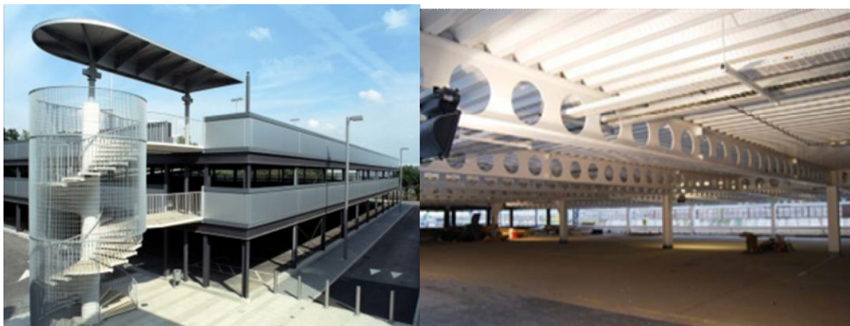
Рис. 1.31. Многоэтажный паркинг со стальным каркасом
