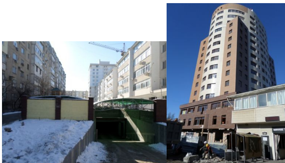
Рис. 1.24. Слева – жилой дом по ул. Суеркулова (бывш. Донецкая) с подземной автостоянкой на 30 машино-мест; справа – жилой дом по ул. Байтик-Баатыра – Дружбы с подземной автостоянкой на 14 машино-мест.
