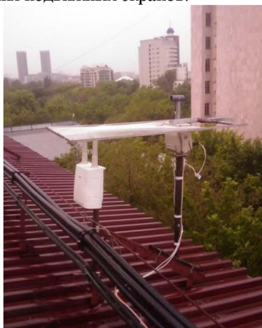
Рисунок 3 - Экспериментальная установка на крыше корпуса Б АУЭС
