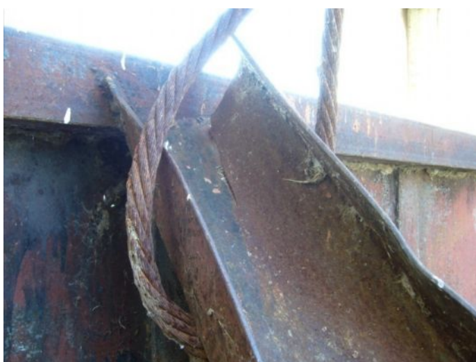
Рис. 4.7. Трещины на верхней части поясов ног порталов V сегментного затвора
