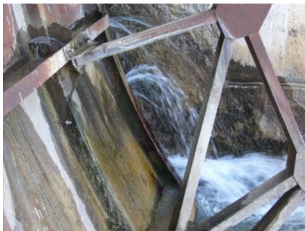
Рис. 4.2. Коррозионные повреждения элементов сегментного затвора
