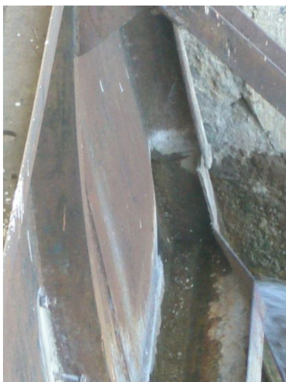
Рис. 4.9. Деформированная обшивка и оторванный сварочный стык правой опорной балки II сегментного затвора
