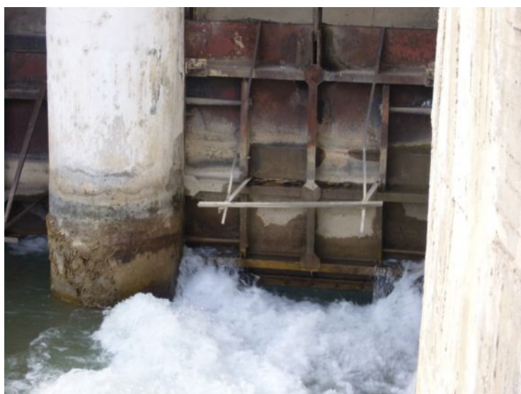
Рис. 4.4. Коррозионные повреждения затворов канала для подачи воды на завод минеральных удобрений и ПМК
