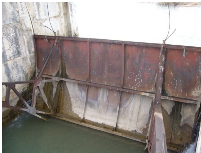
Рис. 4.8. Сорванные тросы V сегментного затвора
