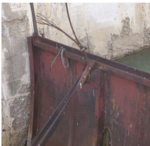
Рис. 4.6. Деформированные части верхних поясов ног порталов V сегментного затвора
