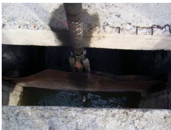
Рис. 4.3. Коррозионные повреждения шлюзовых затворов
