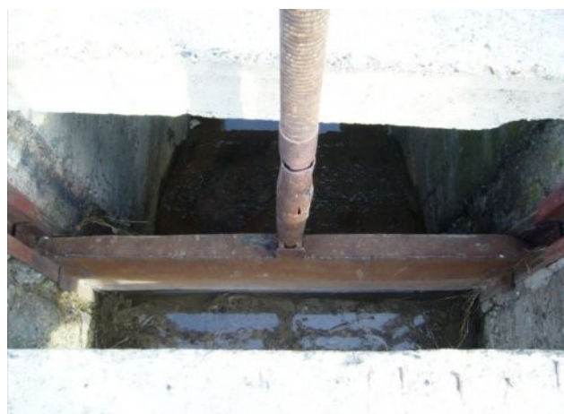
Рис. 4.3. Коррозионные повреждения шлюзовых затворов
