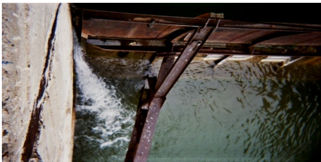
Рис. 4.5. Отсутствие боковых уплотнений сегментного затвора
