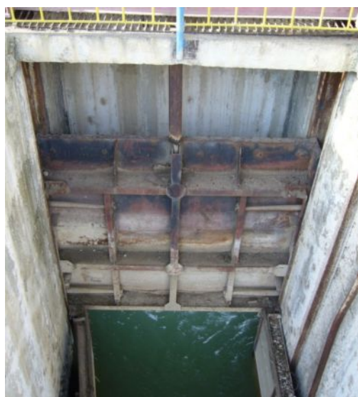
Рис. 4.4. Коррозионные повреждения затворов канала для подачи воды на завод минеральных удобрений и ПМК
