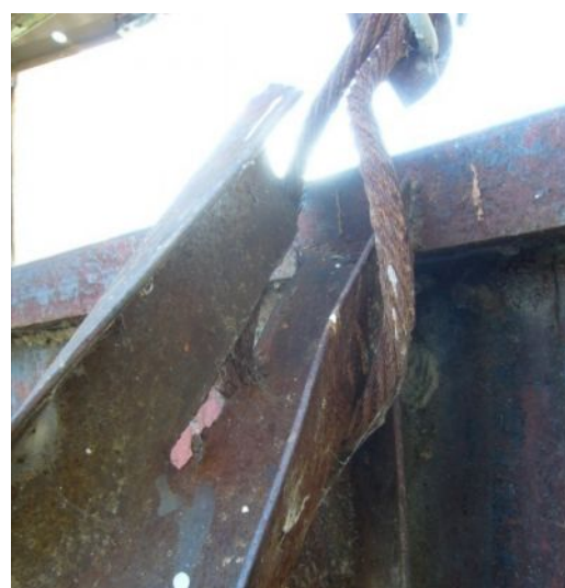
Рис. 4.7. Трещины на верхней части поясов ног порталов V сегментного затвора
