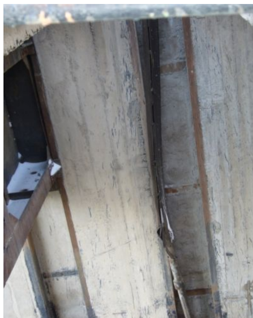
Рис. 4.12. Неудовлетворительное состояние винтовых подъемников донных галерей на ЛМК
