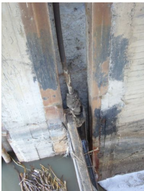
Рис. 4.12. Неудовлетворительное состояние винтовых подъемников донных галерей на ЛМК
