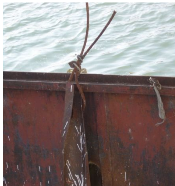
Рис. 4.6. Деформированные части верхних поясов ног порталов V сегментного затвора
