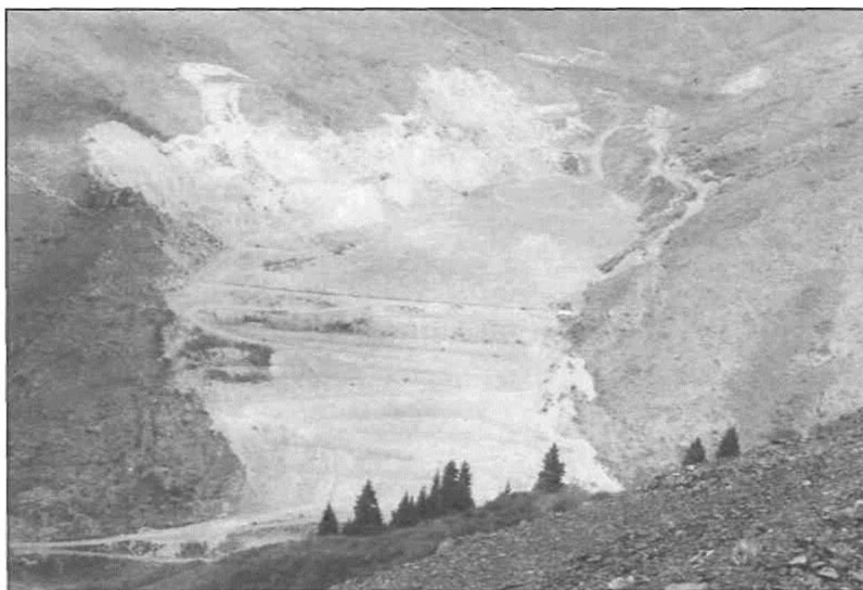
Рис. 2. Хвостохранилище №2 в пос. Ак-Тюз
