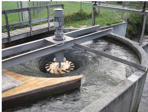
Рис.1 Водоворотная микро ГЭС
