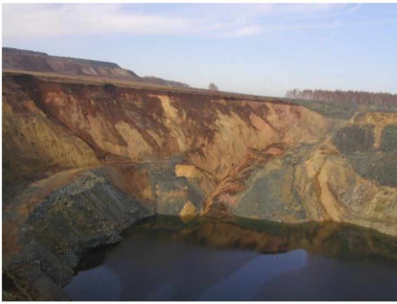
Рис. 1. Инженерно-геологические процессы, происходящие в бортах карьера
