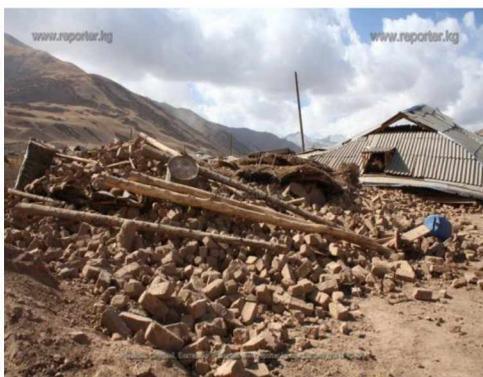
Разновидностью проявления этого концентрированного, узконаправленного типа разрушения является резкая неоднородность размещения сейсмических разрушений в эпицентральных зонах, когда вплотную к полностью разрушенным зданиям примыкают абсолютно невредимые здания. Например, в городе Спитаке, в Нефтегорске и в с.Нура вокруг площадки, покрытой горами обломков, остались, стоять рядом невредимые здания.
