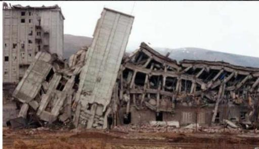
Рис.3 Характер разрушения в зоне Спитакского землетрясения
