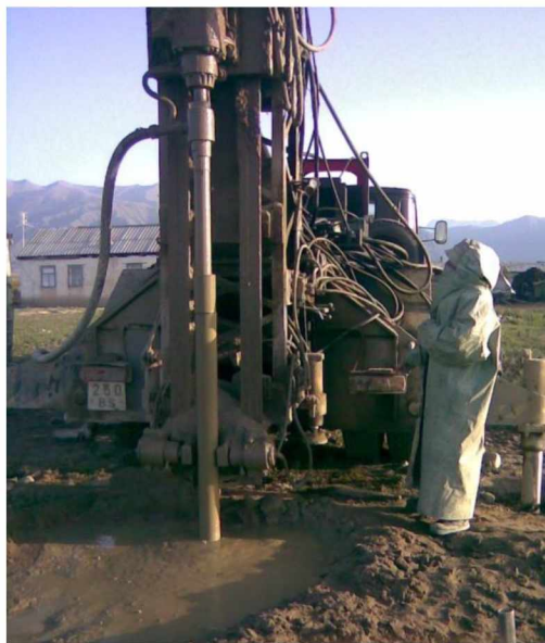
Рис.2. Универсальная бурильная машина типа БМ 25 при бурении скважины на воду
