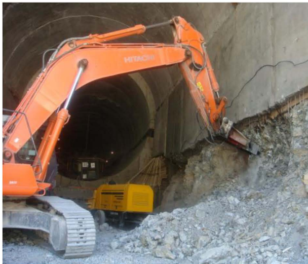
Рис. 6. Отбойный агрегат с гидравлическим молотом Импульс 321 на строительстве ГЭС Камбарата 2
