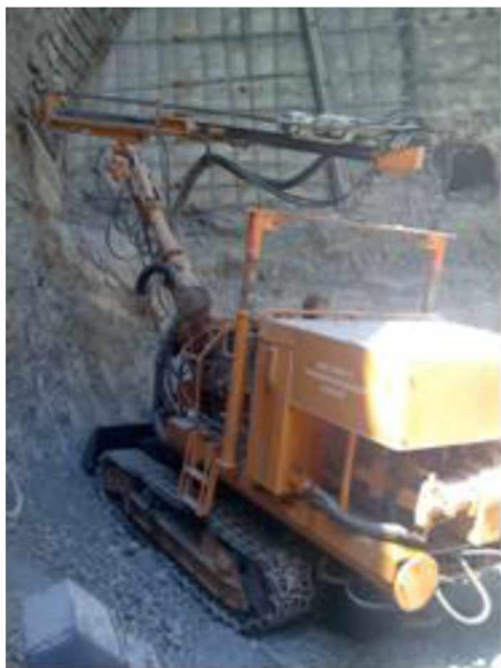
Рис. 1. Буровая установка типа БМ-18 на строительстве ГЭС Камбарата 2
