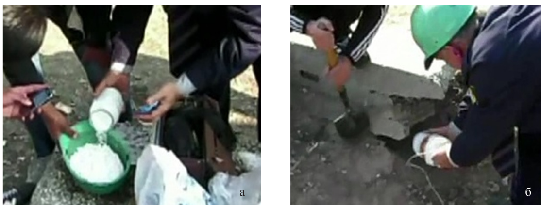
Рисунок 7 – Приготовление состава ФПА-1: а) подготовка заряда; б) Размещение заряда
