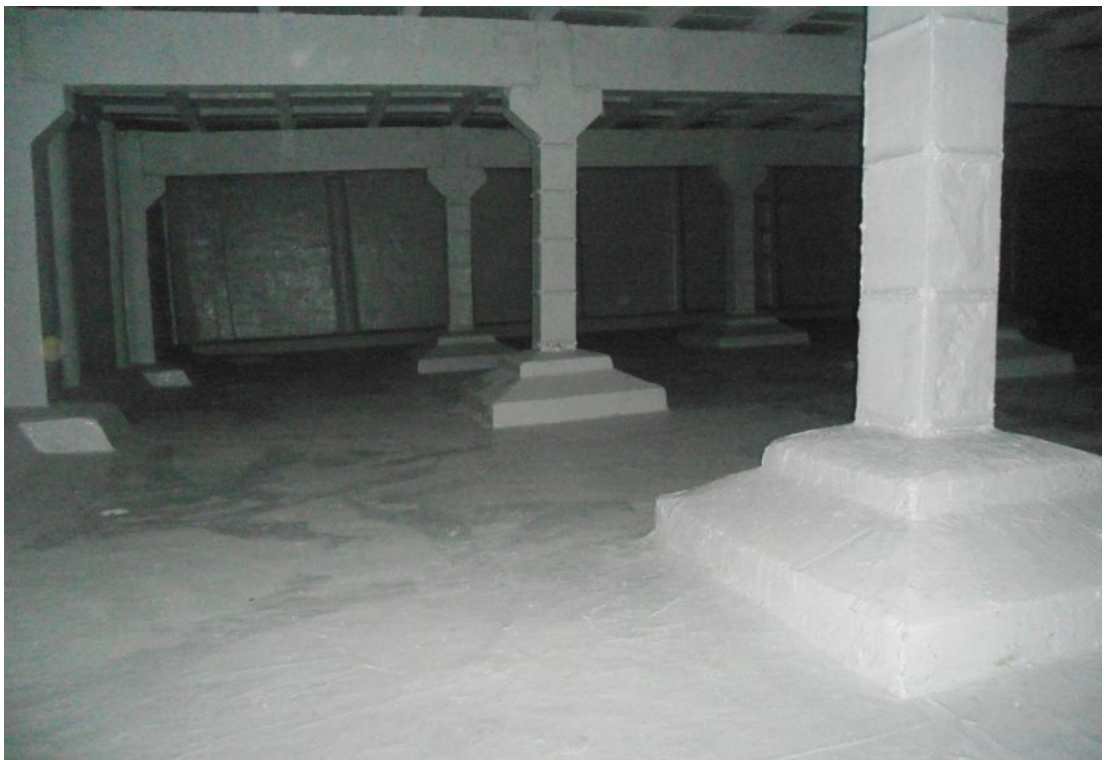
Фото 16 Вид резервуара чистой воды после восстановительных работ
