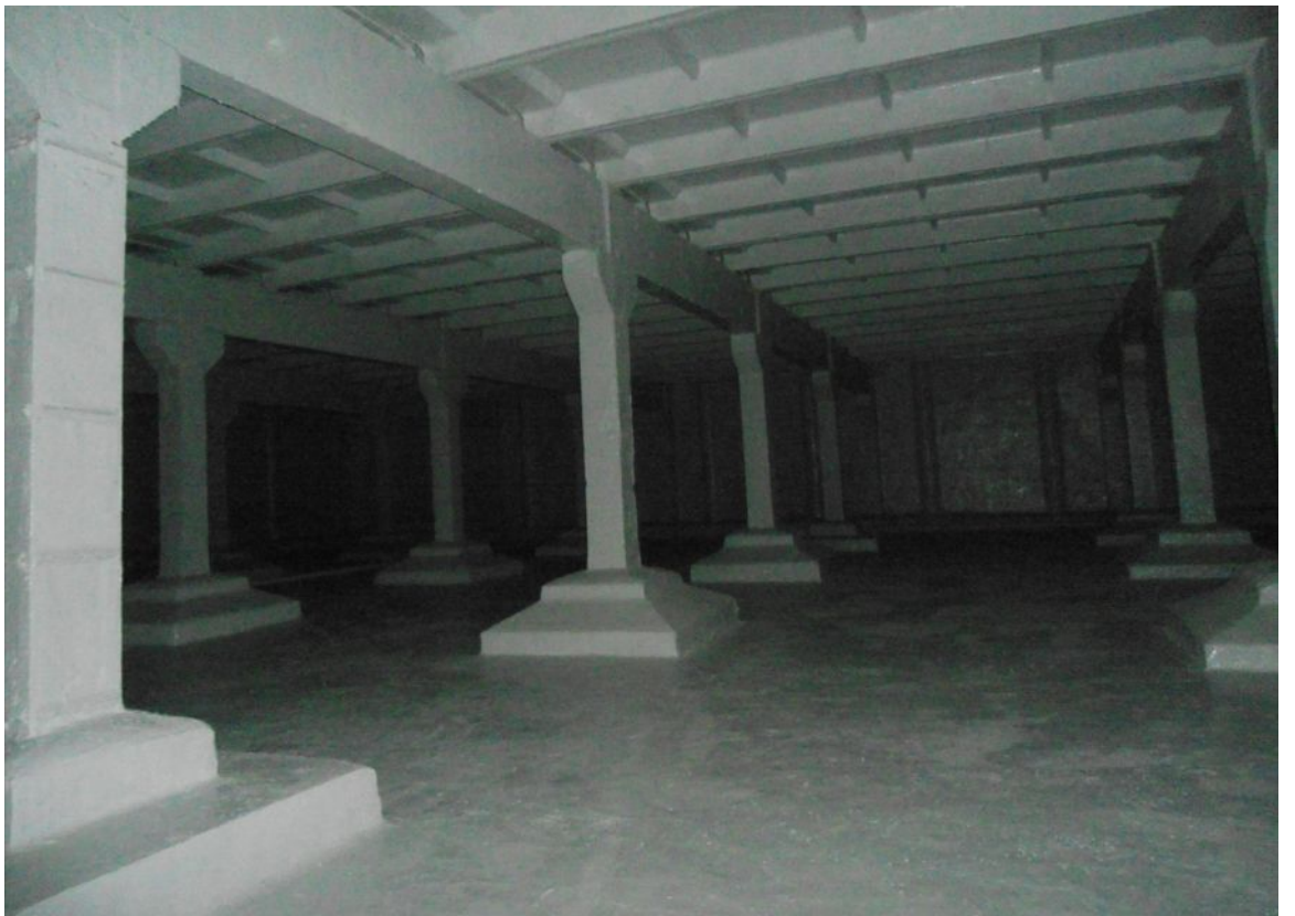
Фото 20 Вид резервуара чистой воды после восстановительных работ
