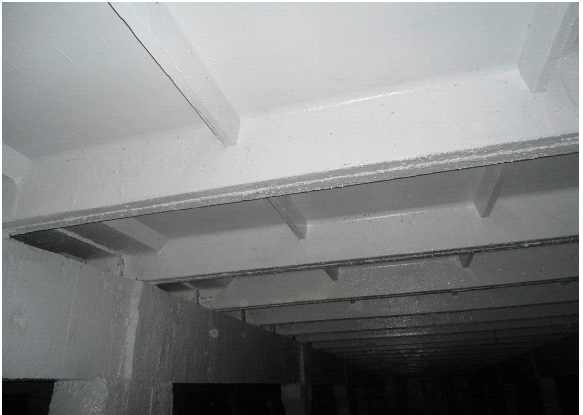
Фото 23 Вид резервуара чистой воды после восстановительных работ
