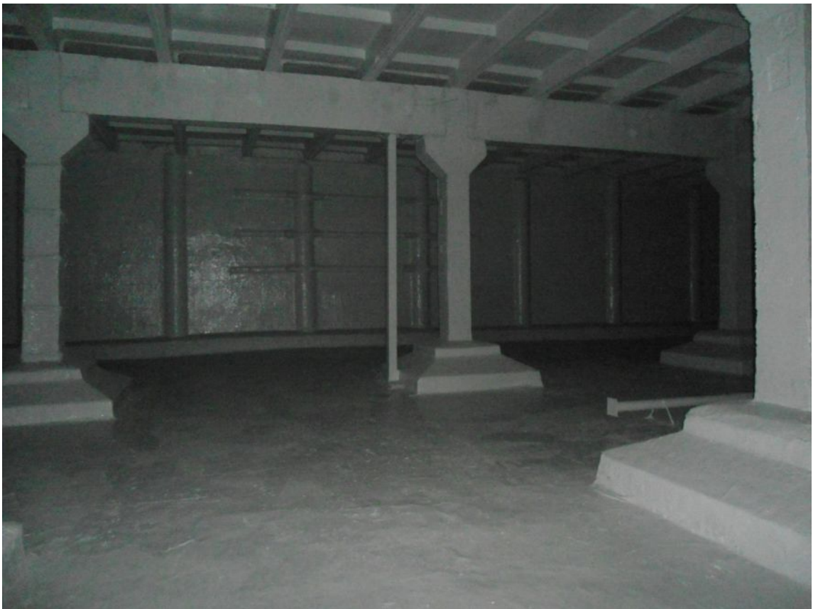
Фото 21 Вид резервуара чистой воды после восстановительных работ
