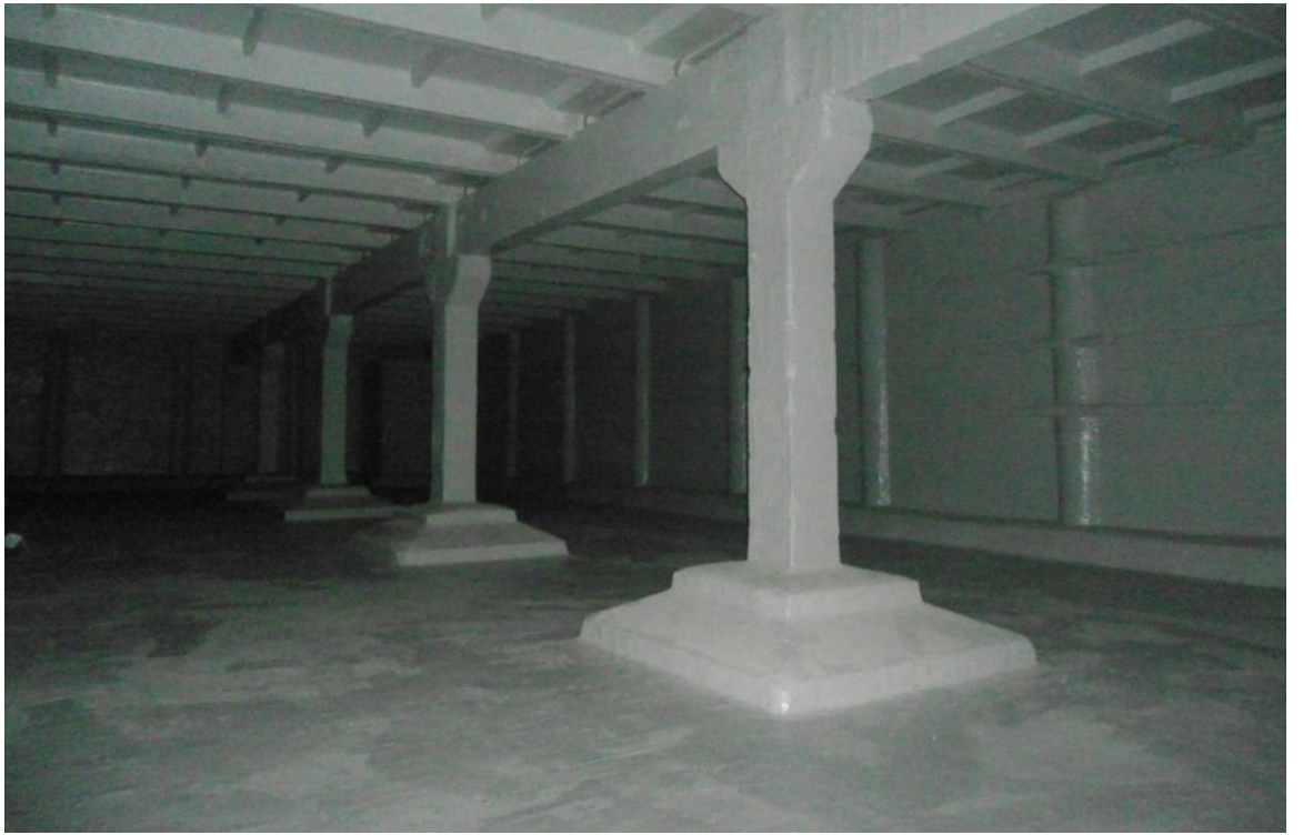
Фото 19 Вид резервуара чистой воды после восстановительных работ
