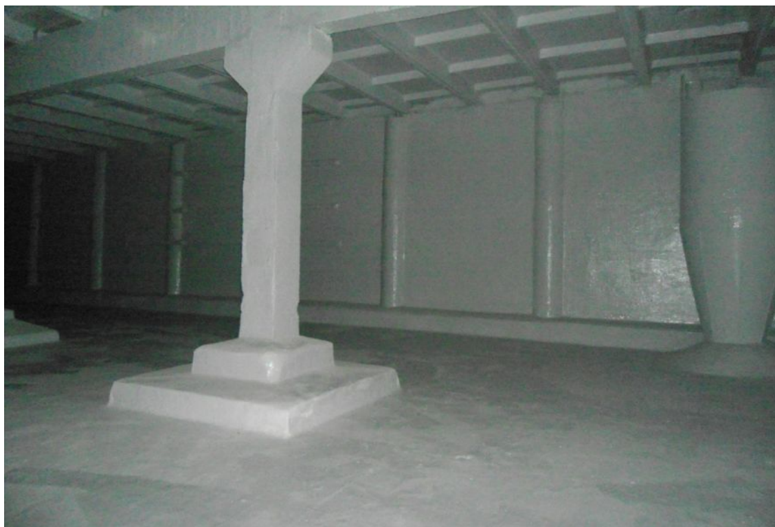
Фото 17 Вид резервуара чистой воды после восстановительных работ
