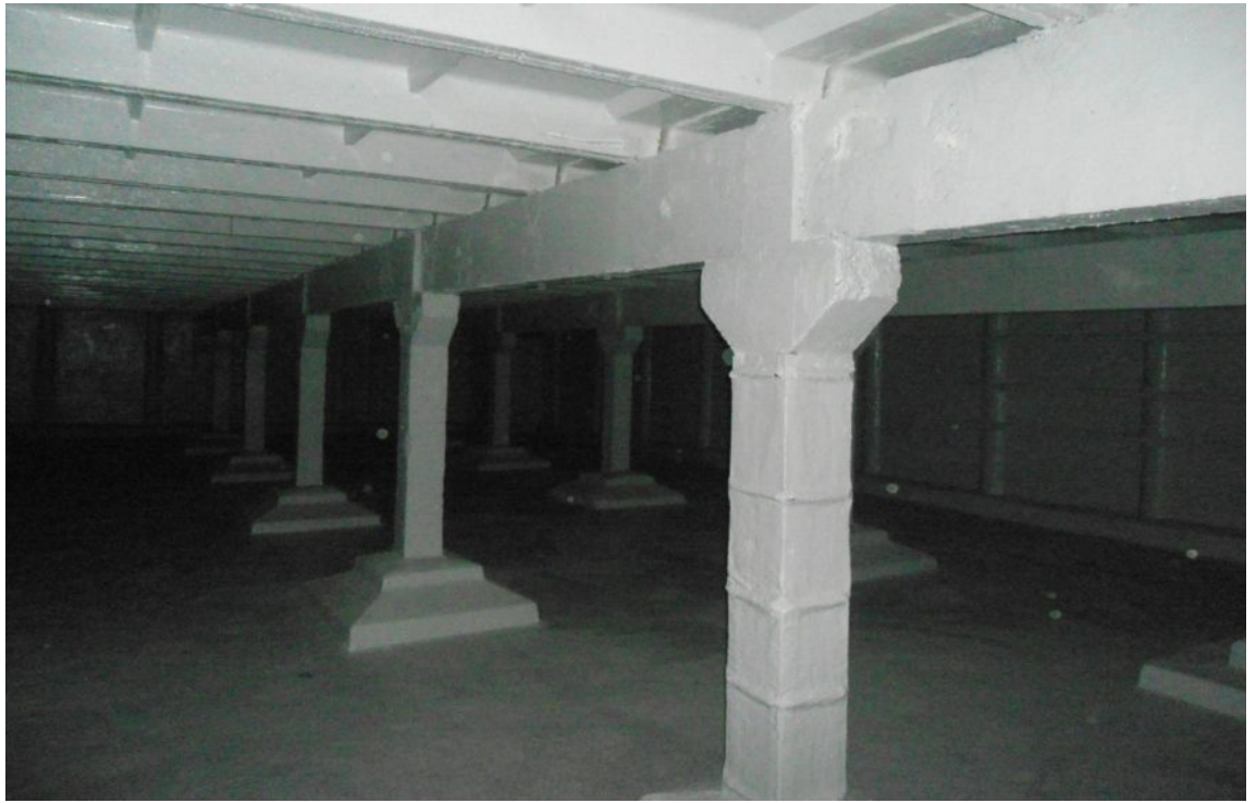
Фото 23 Вид резервуара чистой воды после восстановительных работ
