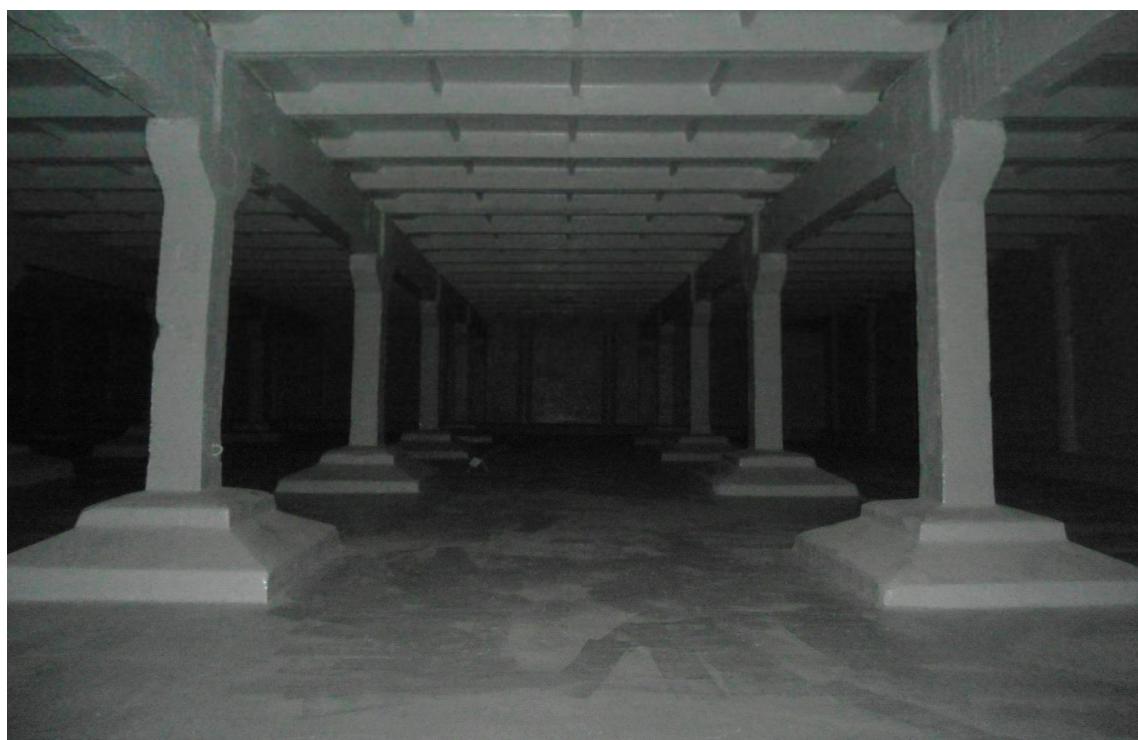
Фото 18 Вид резервуара чистой воды после восстановительных работ
