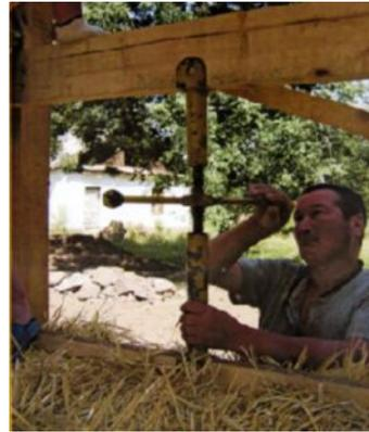
**Рис. 4 – Винтовой пресс**
