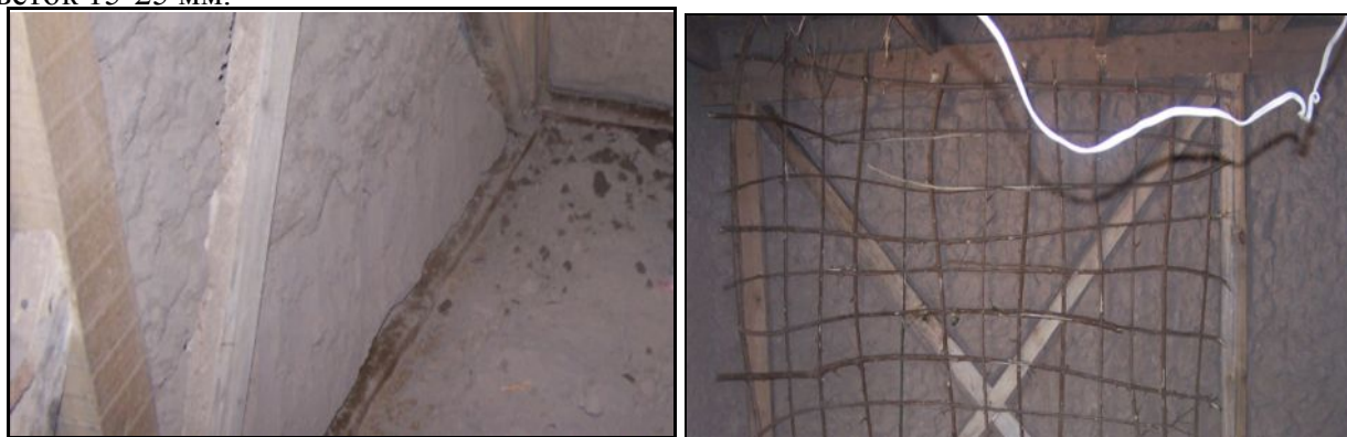
Рис.2. Каркас и сетка из прутьев установленные в стену
