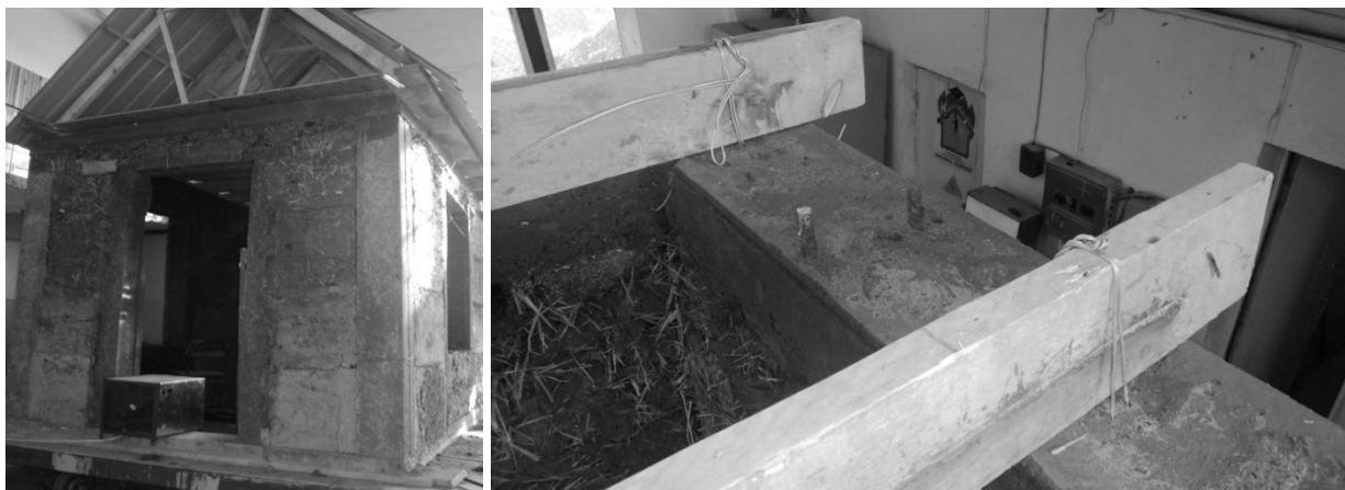
Рис. 5. Процесс возведения модели дома из “железобетонного каркаса”
