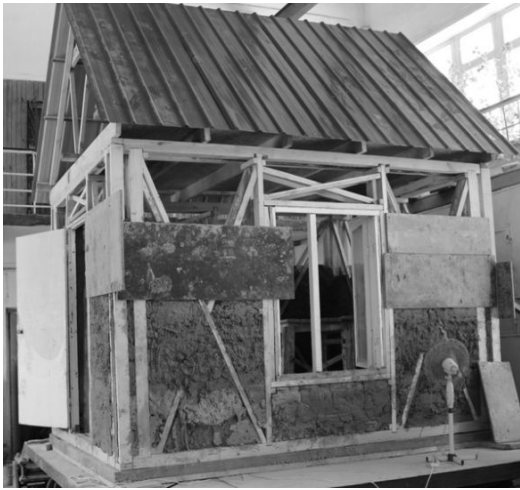
Рис. 3. Процесс возведения модели дома из деревянного каркаса “Сынч”
