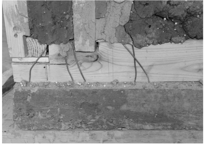
Рис. 3. Процесс возведения модели дома из деревянного каркаса “Сынч”
