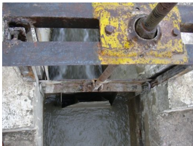
Рис.3.4. Автоматизированный водовыпуск на распределительном канале в Учхозе КНАУ: а – вид с верхнего бьефа; б – вид сверху на затвор-стабилизатор.
