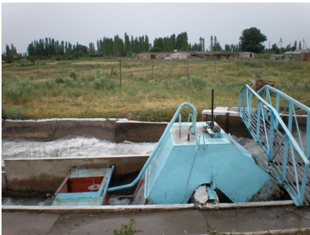
Рис.2.3. Сифонный регулятор расхода воды(фото 2012 г.).
