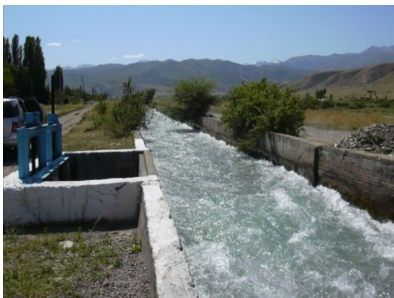
Рис.3.5. Вододелитель-стабилизатор на канале-быстротоке ИПК в процессе работы.
