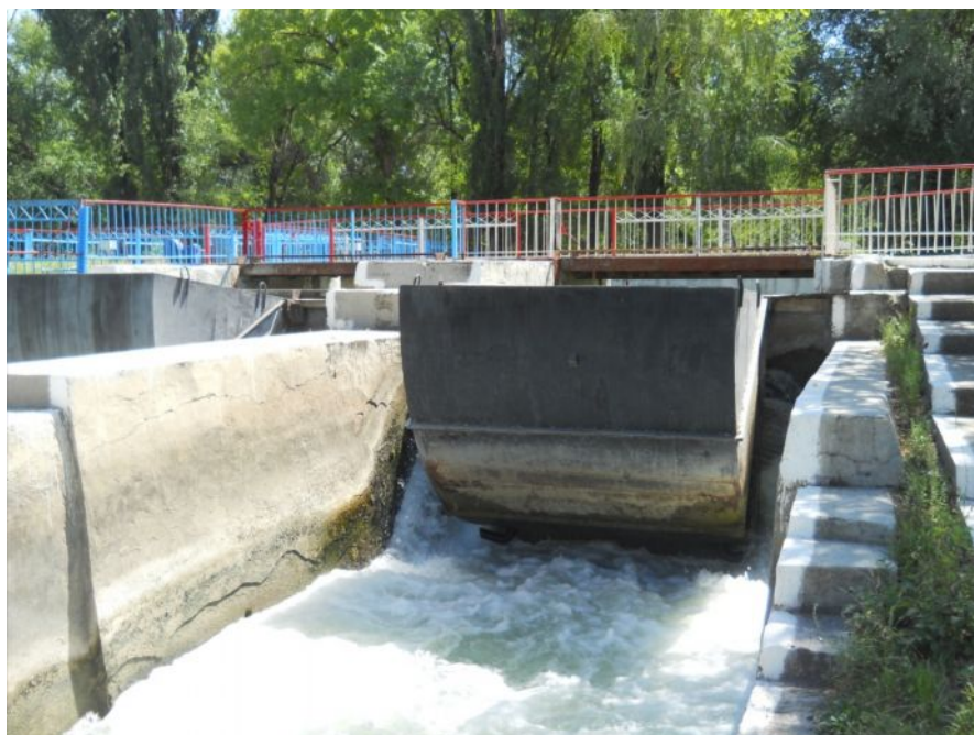
Рис.2.6. Головное сооружение Ат-Башинского магистрального канала.
