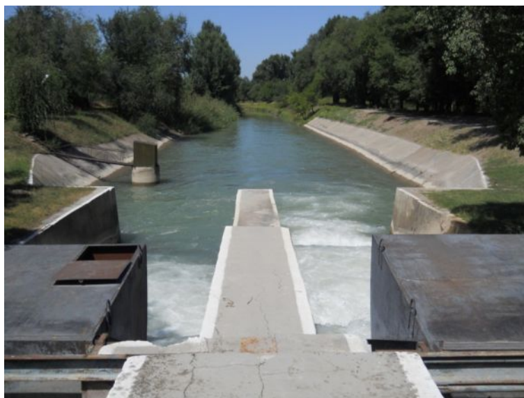
Рис.3.9. Вид на водомерный пост в нижнем бьефе сооружения.
