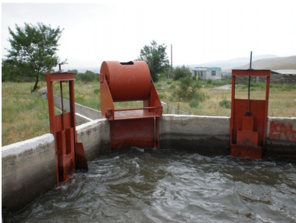
Рис.2.9. Водораспределительное сооружение на канале «Джаламыш».
