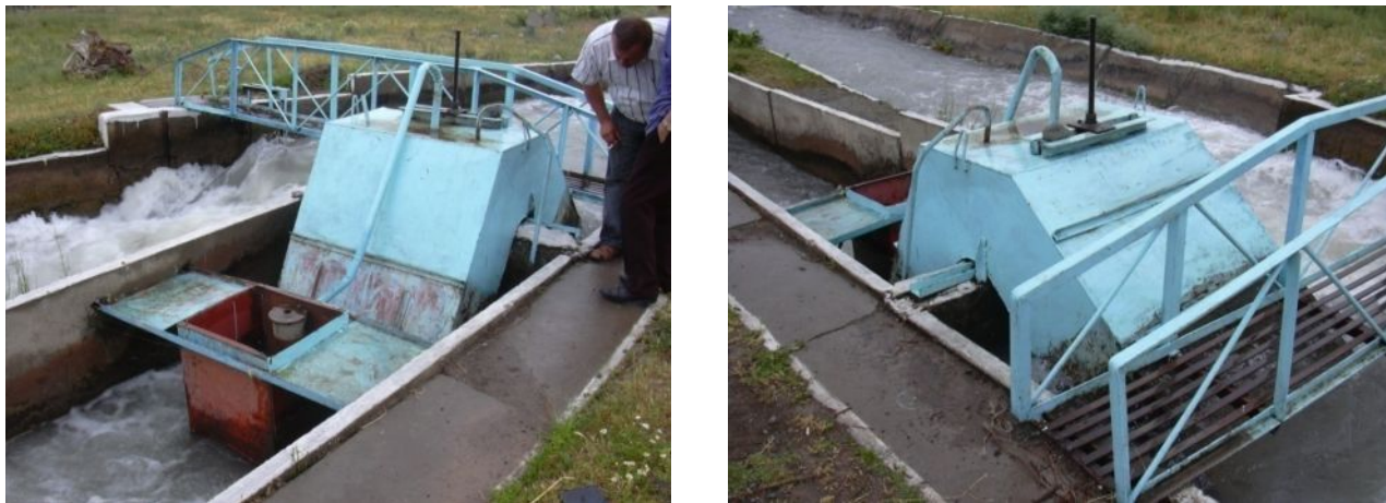
Рис.3.3.Изучение характеристик водовыпуска - автомата сифонного типа: а – в нижнем бьефе сооружения; б – в верхнем бьефе.
