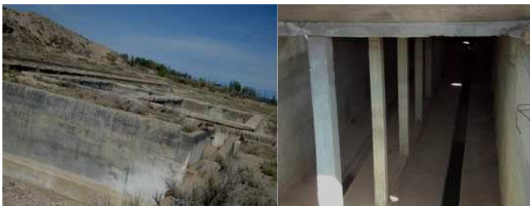
Рис.4.24. Бассейны для осаждения урана и специальные подземные коммуникации, по которым иссык-кульская вода поступала в бассейны.
