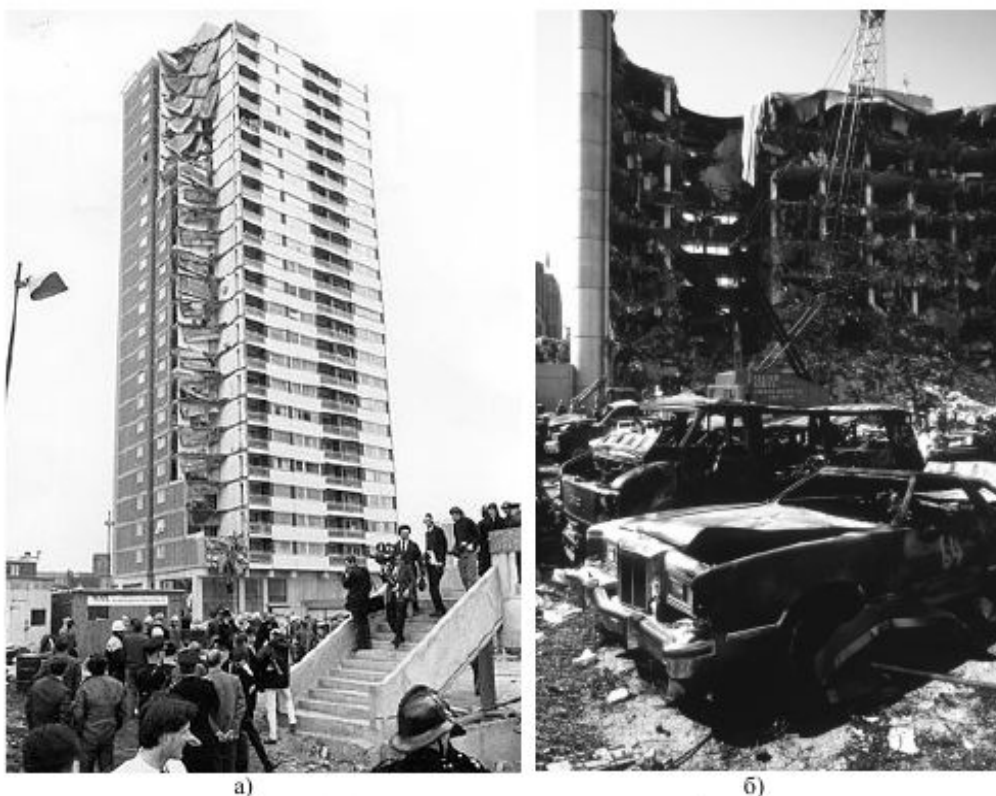
Рис. 1. Примеры прогрессирующего обрушения: а – здание «Ronan Point», б – здание в Оклахома-Сити
