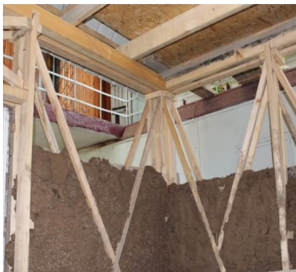
6-Сүрөт. «Сынч» түрүндөгү үйдүн моделинин өзөктөрүнүн ичин толтуруу
