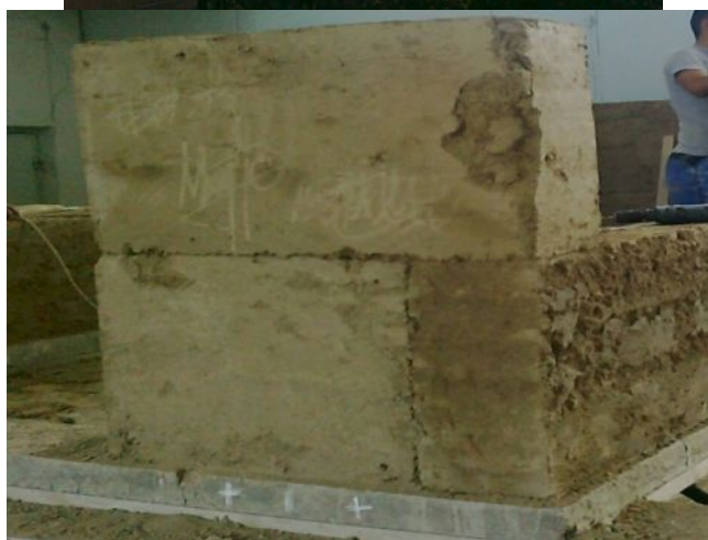
а) б) 1-Сүрөт. «Сокмо» дубалдын тургузуу учурлары: а) - сокмо –сок билекти колдонуу учуру; б) – тургузуунун айрым көрүнүштөрү
