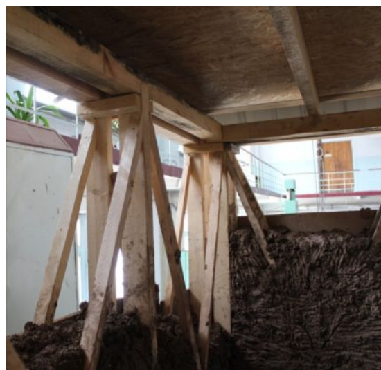
6-Сүрөт. «Сынч» түрүндөгү үйдүн моделинин өзөктөрүнүн ичин толтуруу
