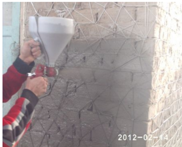
3-Сүрөт. «Жер титирөөгө туруктуу курулуш» лабораториясында чийки кыштан тургузулган үйдүн модели
