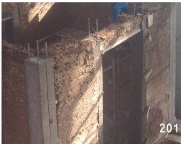
8-Сүрөт. Темир –бетон өзөктүү жана өзөктүн аралыгы саман аралашкан ылай менен толтурулган үйдүн моделин тургузуунун ыкмалары
