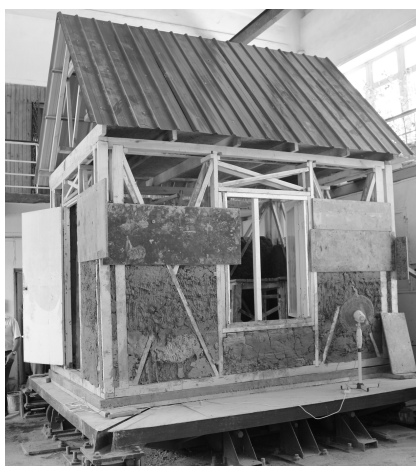
Рис. 2. Модель дома «сынч» в процессе строительства
