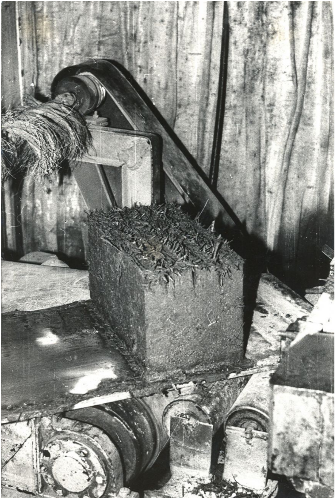
Рис. 1. Отформованный стеновой блок из сечки соломы с применением полимерсиликатно-гипсового вяжущего
