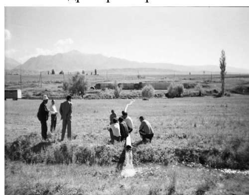
Рис. 9. Выход в ороситель на высоту 13,5 м
