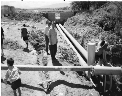
Рис. 6. Запуск спаренных гидротаранов ГТ-400
