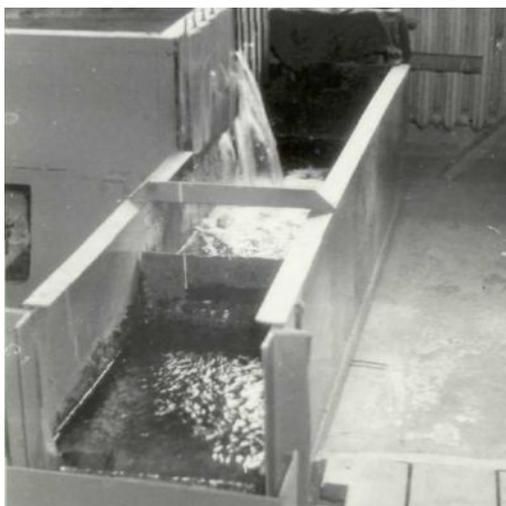
Рис. 3.2. Модель трехпролетного сооружения
