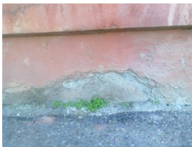
Рисунок 3 – Разрушение фундамента
