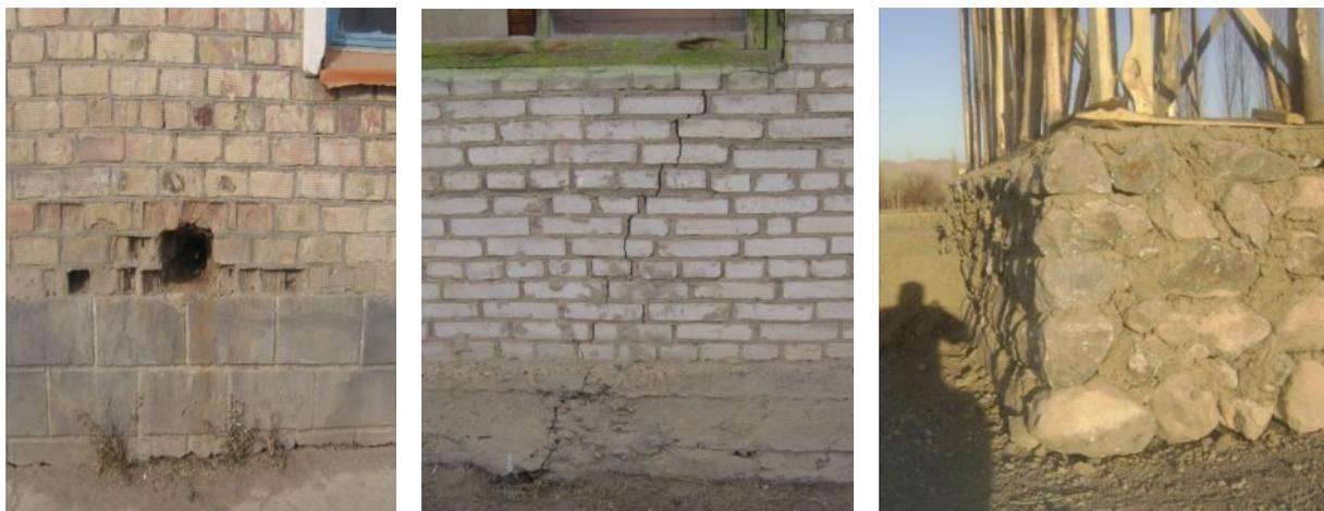
Рис.1. Фундаменты малоэтажных зданий с различными типами несущих конструктивных систем
