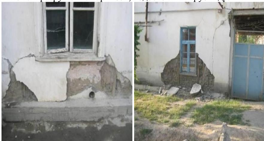
Рис. 2. Повреждения стен сынчевых домов при землетрясении 20.07.2011 г, в Баткенской области, с. Кан.
