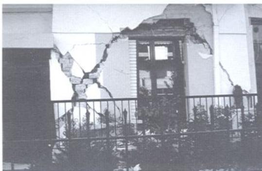
Рис. 2. Трещины между оконными рамами с одновременным нарушением двурядной кирпичной стены
