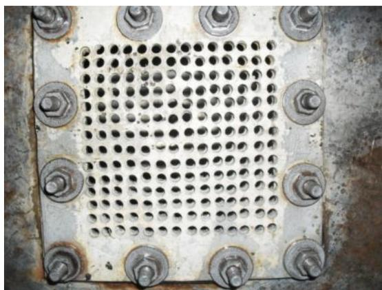
*Рис. 3. Фильтрующие элементы: 1 – нижняя часть корпуса фильтра; 2 – держатель фильтрующего материала; 3- фильтрующий материал; 4 – зажимные болтовые соединения.*
