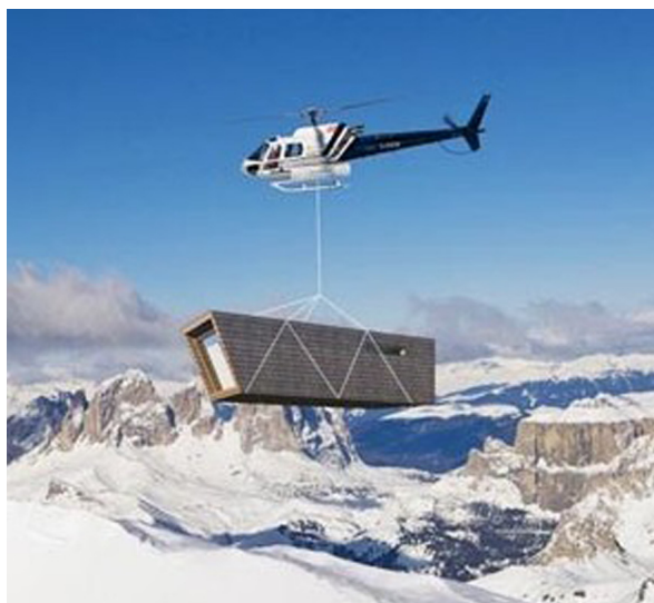
Рисунок 2 – Доставка блок-контейнера
