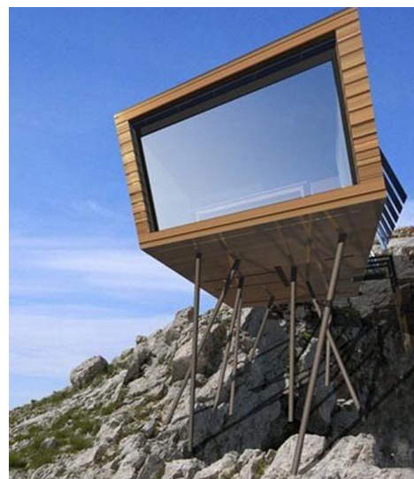
Рисунок 3 – Установка блок-контейнера на скалистый склон воздушным видом транспорта
